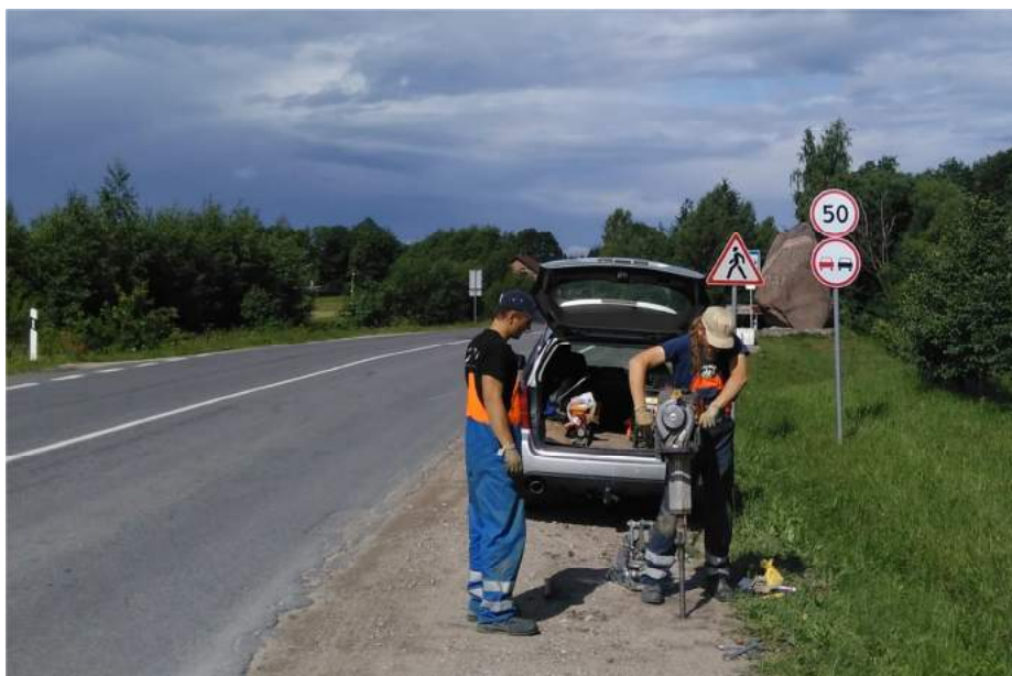
1 pav. Lauko darbai
