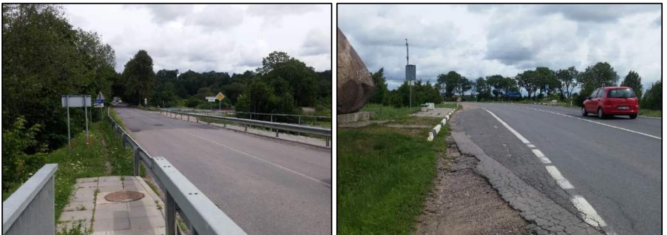
2 pav. Kelio Nr.228 rekonstruojamo ruožo trasos pradžia ir pabaiga
