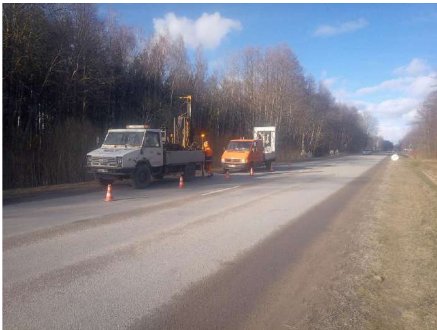
1 pav. Lauko darbai (Gr.7)
