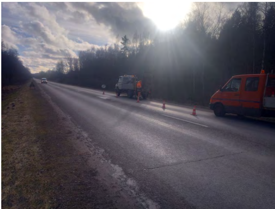
1 pav. Lauko darbai ties gręžiniu Gr.9
