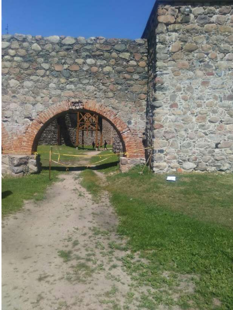
1.2 pav. Lauko darbai
