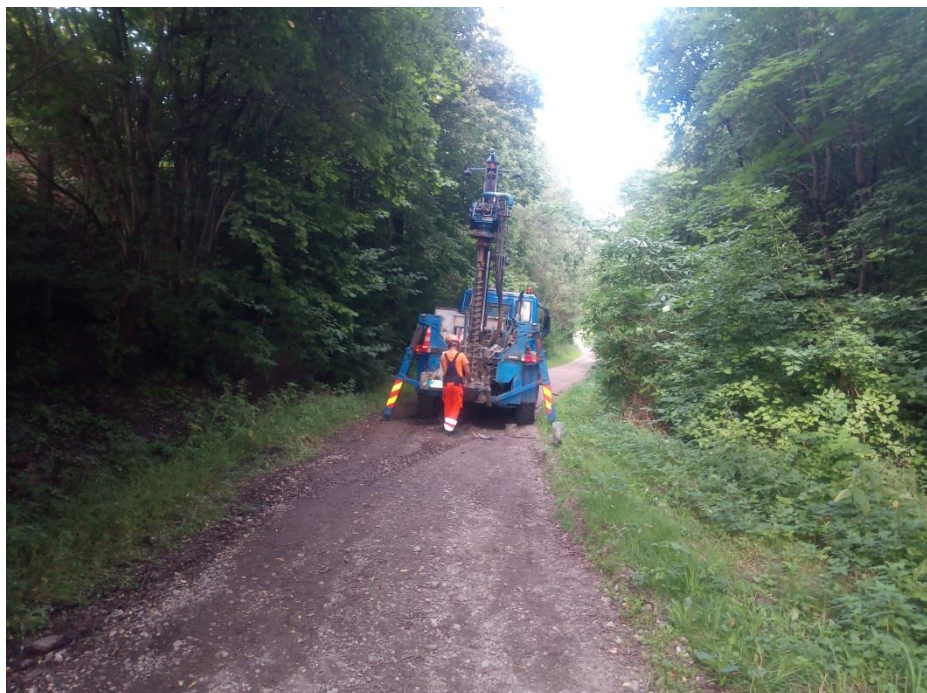
3 pav. Lauko darbai
