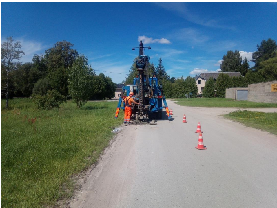
1 pav. Lauko darbai
