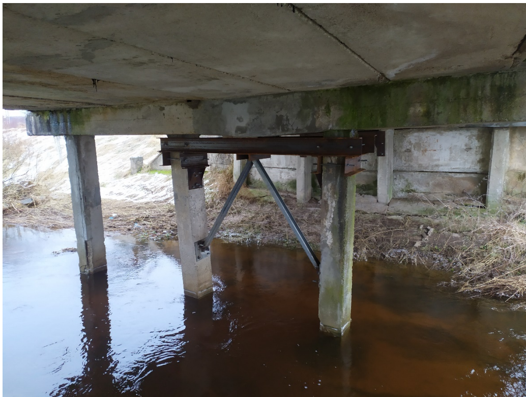
3 pav. Tilto perdangos apačia
