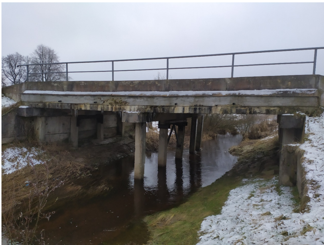
2 pav. Tilto fasadas
