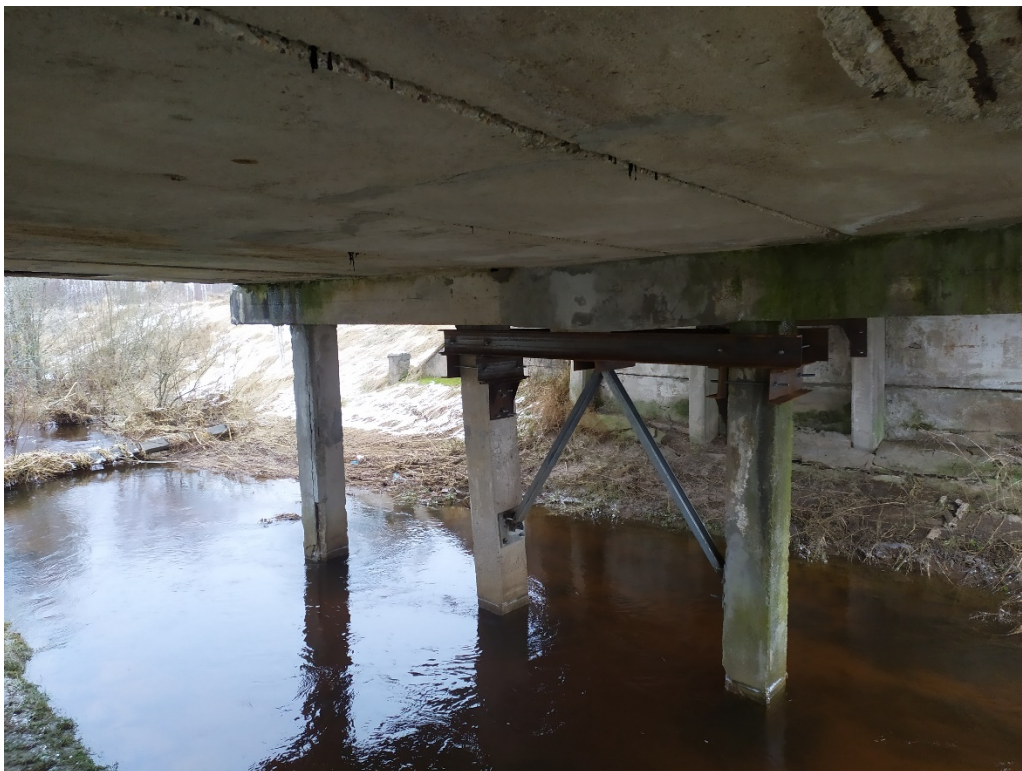
6 pav. Deformaciniai pjūviai nesandarūs
