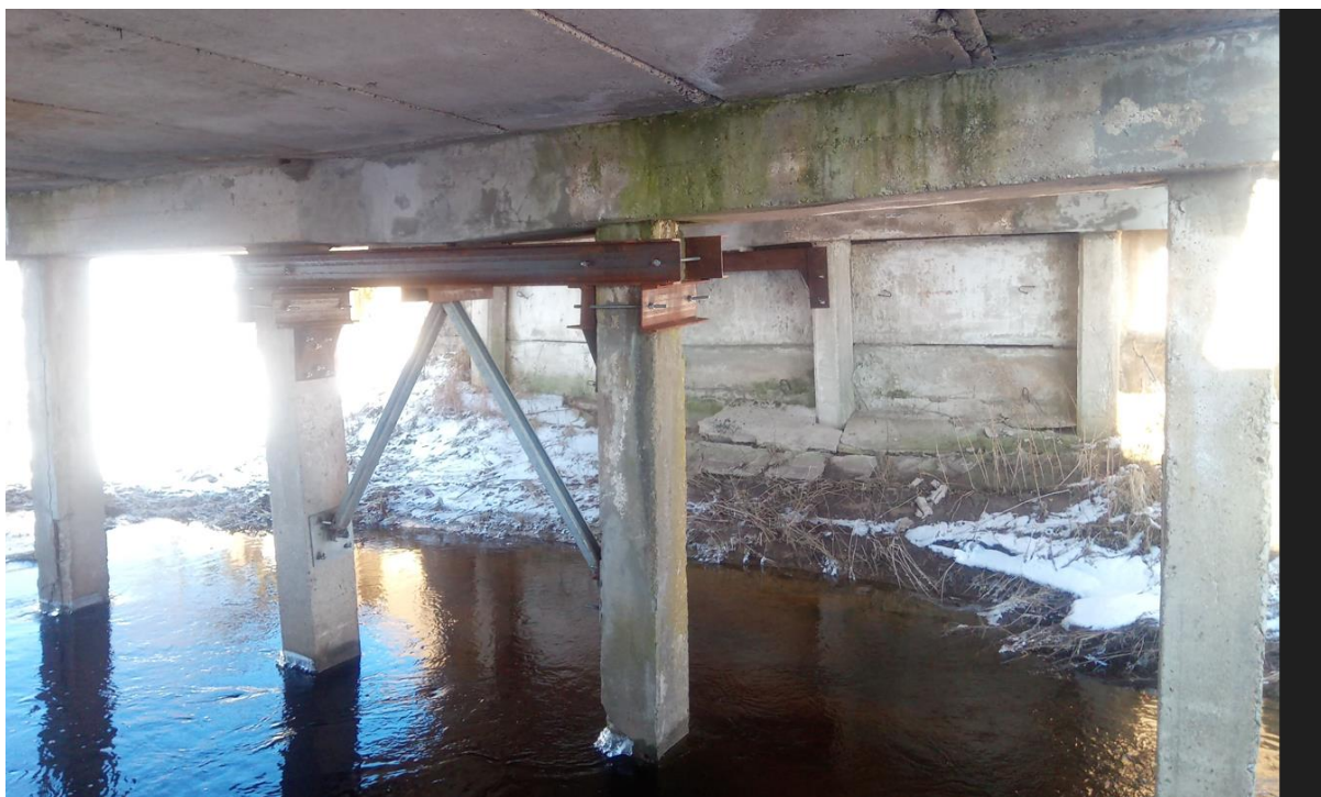
6 pav. Tilto per Suosą būklė. Matomos nuerduotos kolonos.
