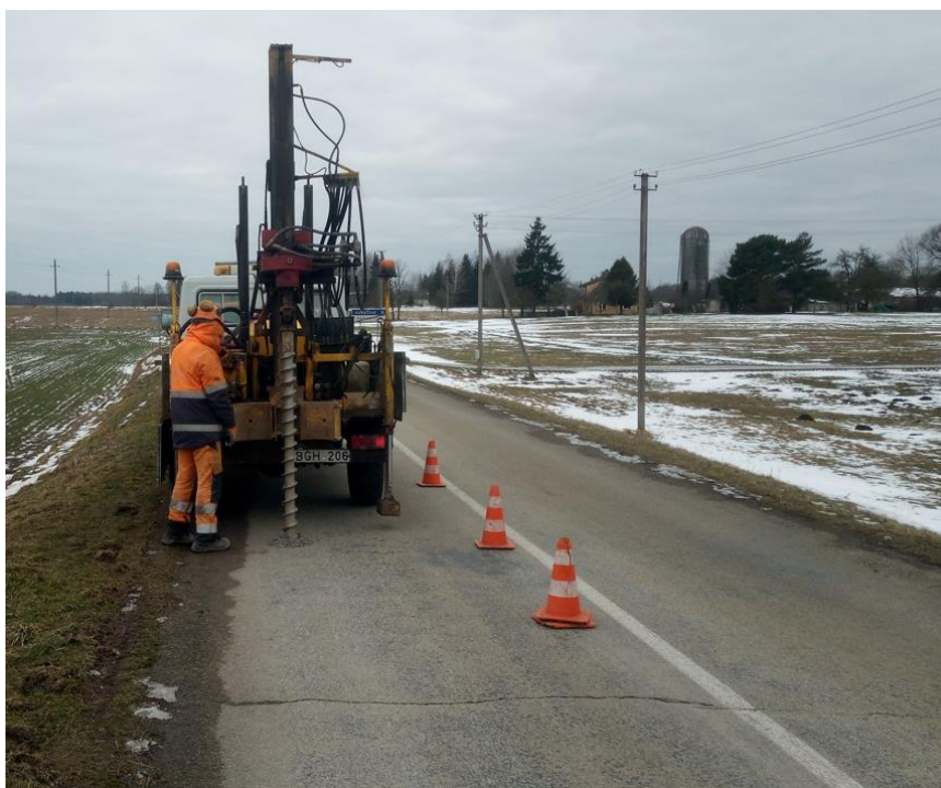
3 pav. Asfalto būklė (gręžinys Nr.1.1)
