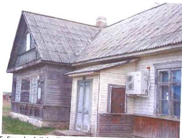
5. Fasado dailylenčių dažai atsilupę, dailylentės apatinėje sienos dalyje pažeistos puvinio.
