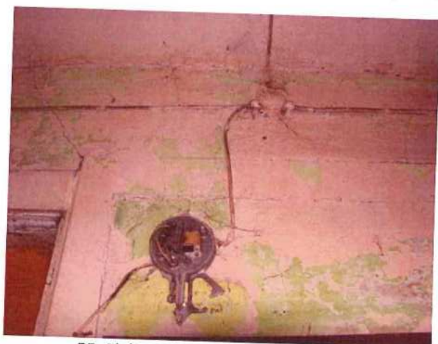
55. Elektros instaliacija susidėvėjusi.
