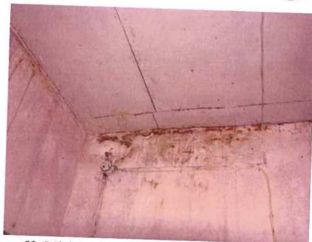
62. Dėl drėgmės pertekliaus ant sienų atsiradęs pelėsis.
