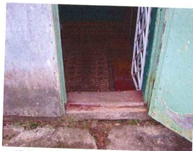
48. Durys turi aukštus slenksčius, kas apsunkina patekimą į patalpas neįgaliesiems.
