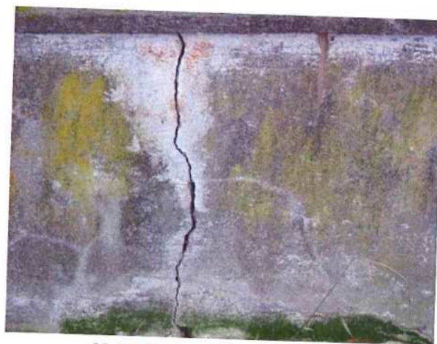
46. Vertikalus plyšys pamatuose.
