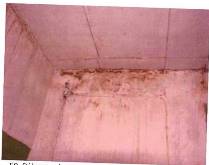
59. Dėl nesandaraus stogo drėkinamos sienos ir lubos.
