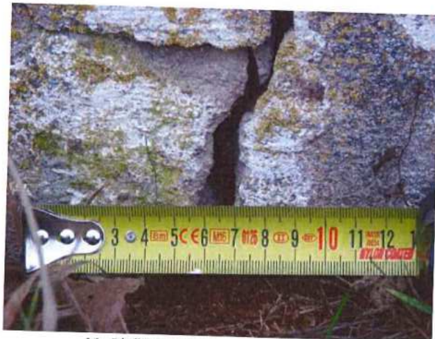
41. Plyšiai pamatuose viršija 5 mm.
