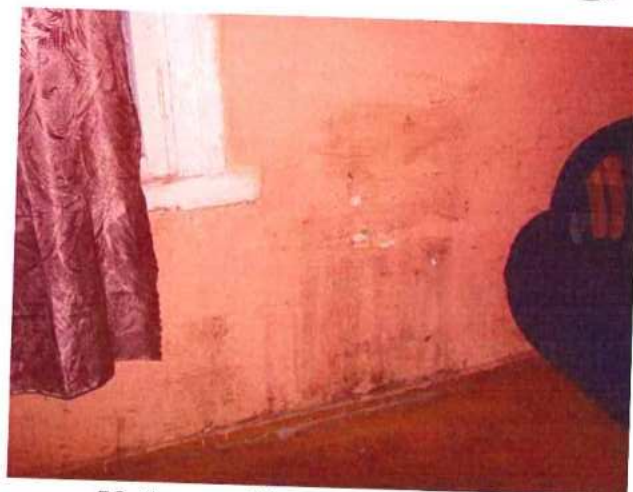
56. Sienų paviršiuje formuojasi pelėsis.
