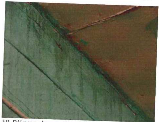
50. Dėl nesandaraus stogo drėkinamos sienos ir lubos.
