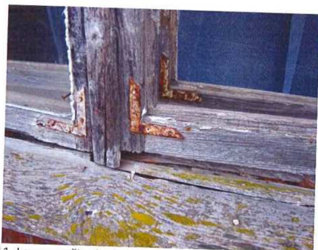
11. Langų varčios ir rėmai pažeisti puvinio. Rėmo apačioje matomi plyšiai.
