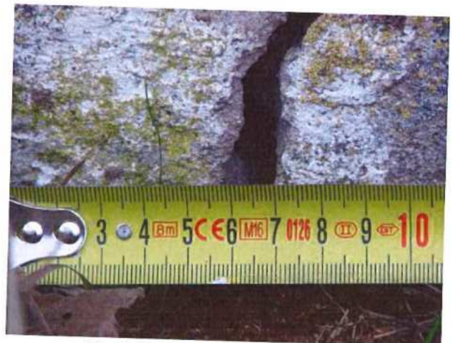
42. Plyšiai pamatuose viršija 5 mm.
