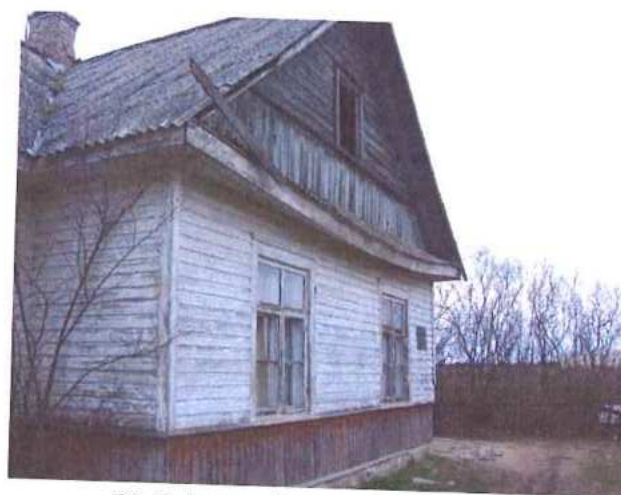
66. Įlinkęs medinis pastato karnizas.
