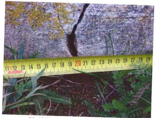
38. Plyšiai pamatuose viršija 5 mm.
