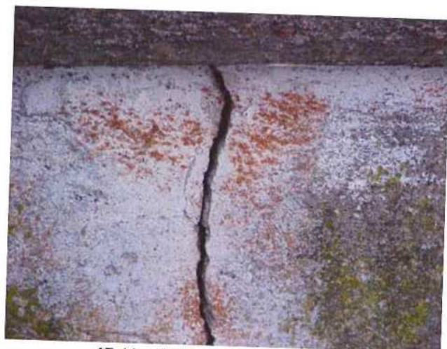
47. Vertikalus plyšys pamatuose.
