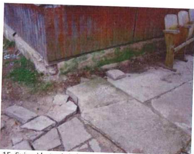
15. Suirusi betoninė danga ties pastato galiniu jėjimu.
