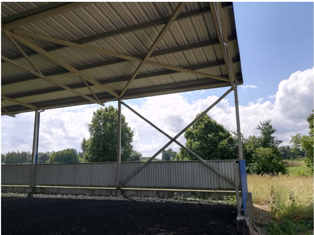
04 pav. Statinio k2 (Unik. Nr. 4400-2459-8241) konstrukcijų fotografacija
