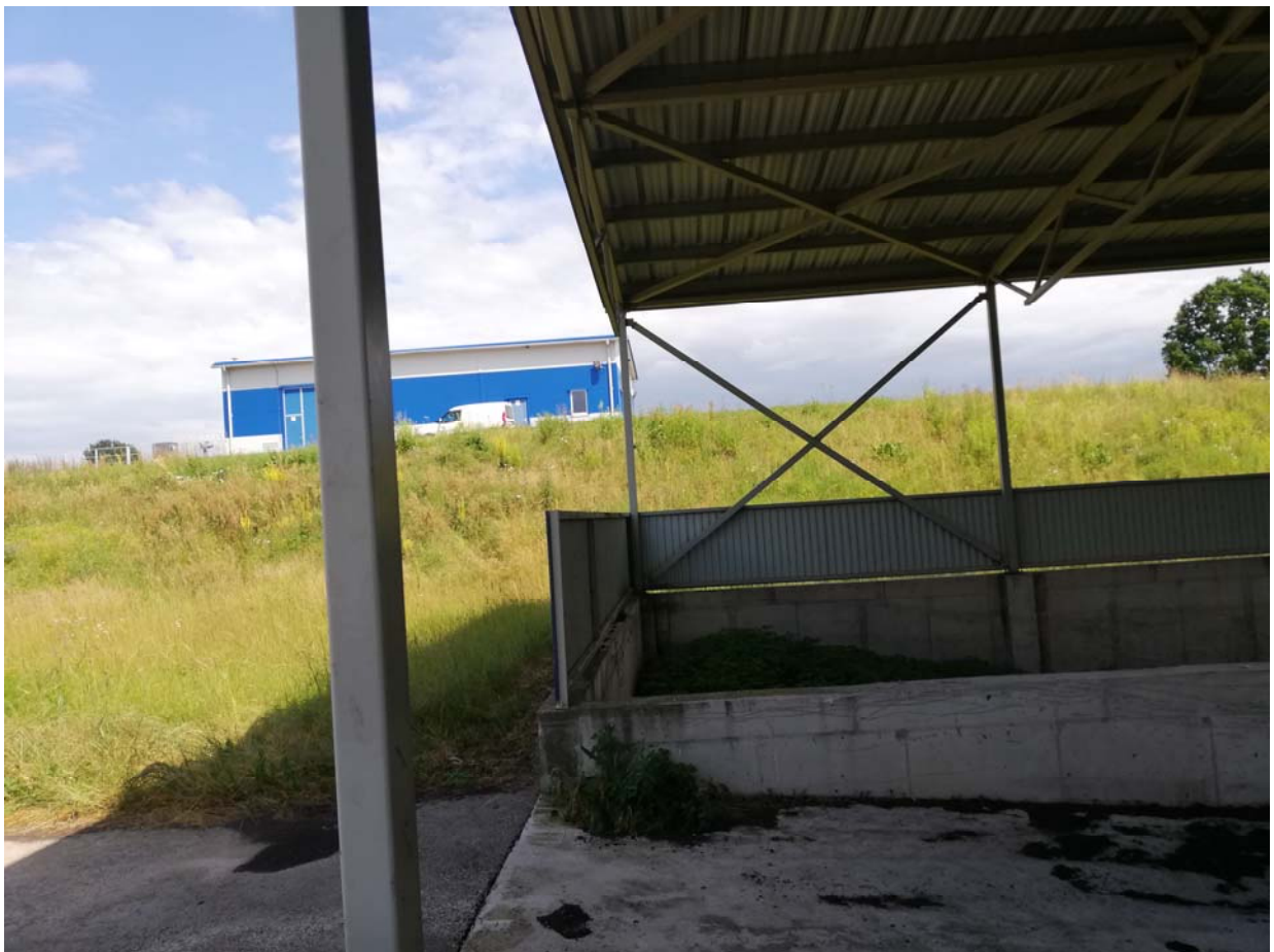
06 pav. Statinio k2 (Unik. Nr. 4400-2459-8241) konstrukcijų fotografacija
