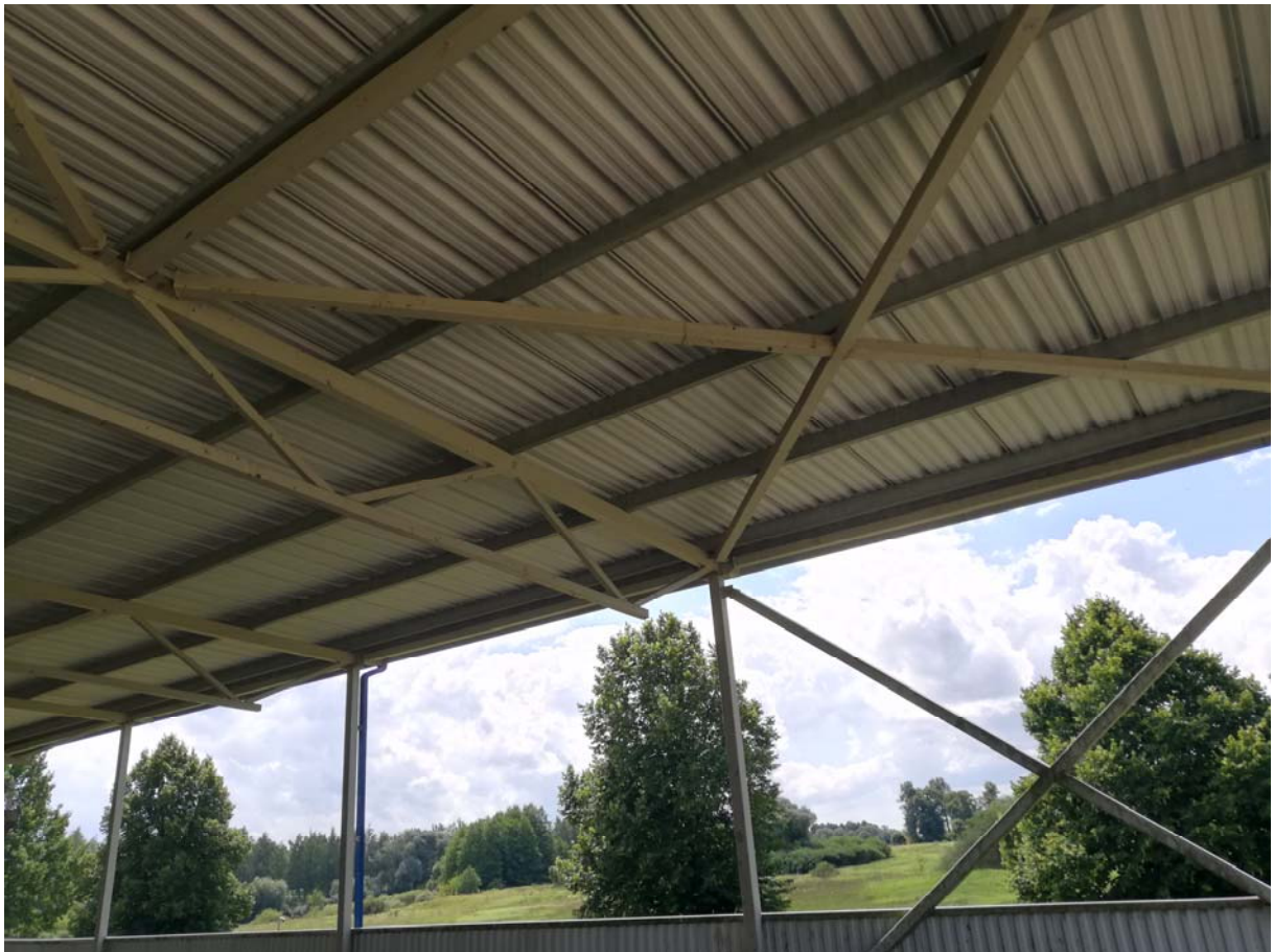
08 pav. Statinio k2 (Unik. Nr. 4400-2459-8241) konstrukcijų fotografacija
