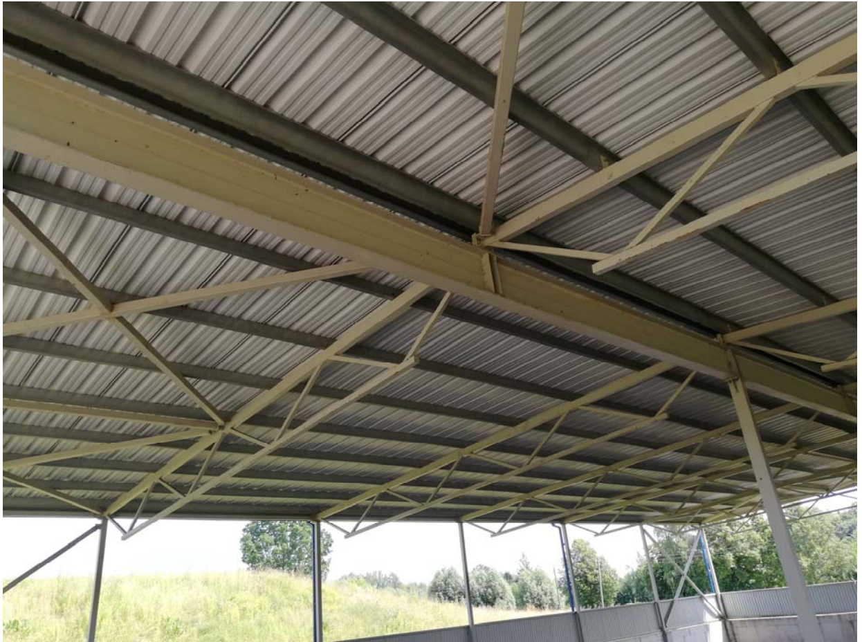
07 pav. Statinio k2 (Unik. Nr. 4400-2459-8241) konstrukcijų fotografacija
