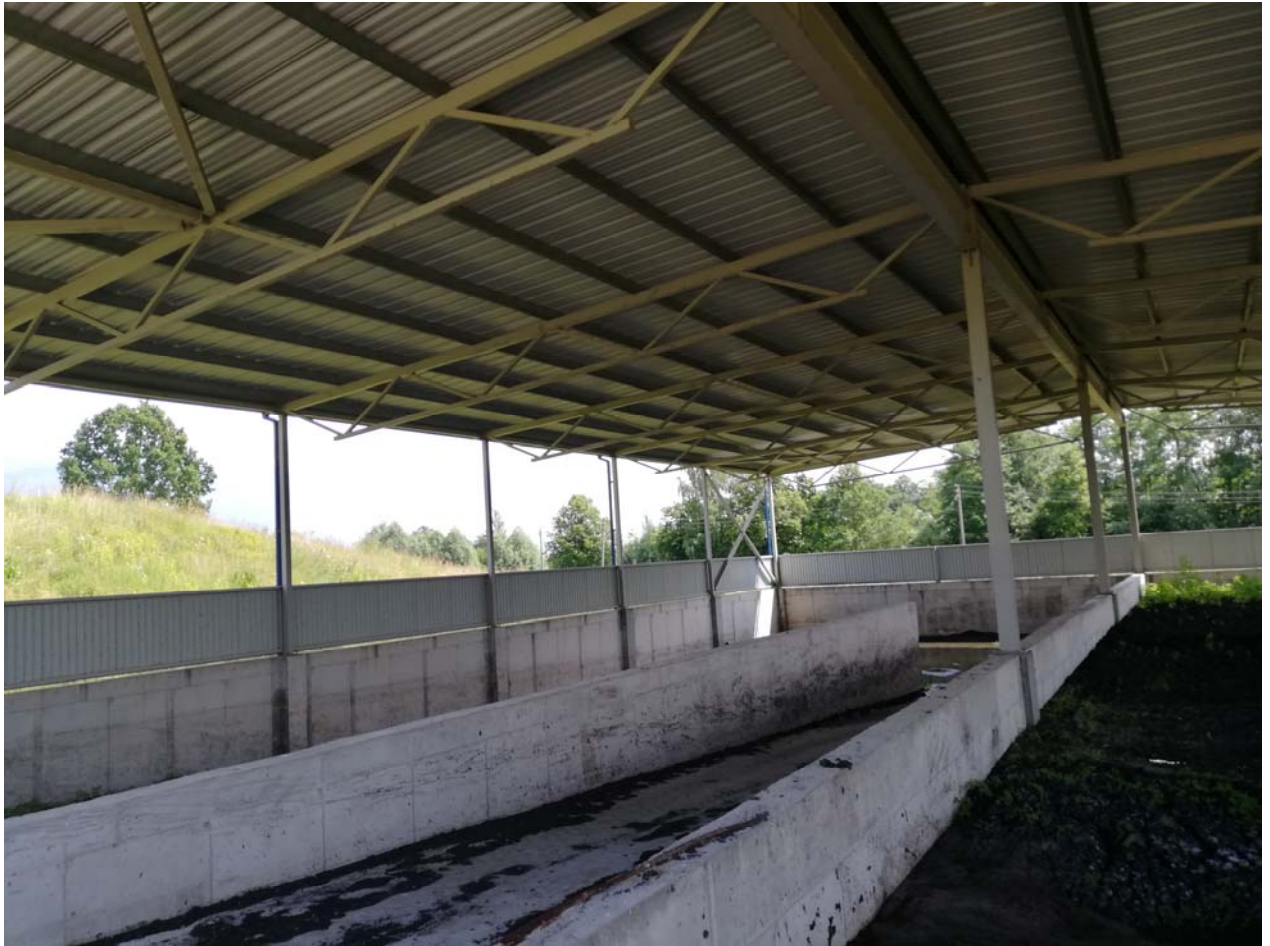
05 pav. Statinio k2 (Unik. Nr. 4400-2459-8241) konstrukcijų fotografacija
