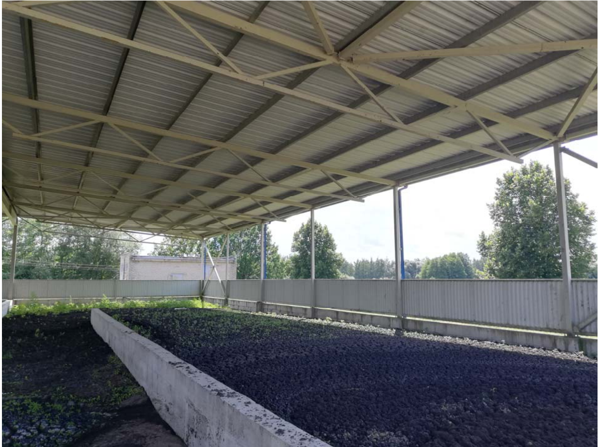
03 pav. Statinio k2 (Unik. Nr. 4400-2459-8241) konstrukcijų fotografacija
