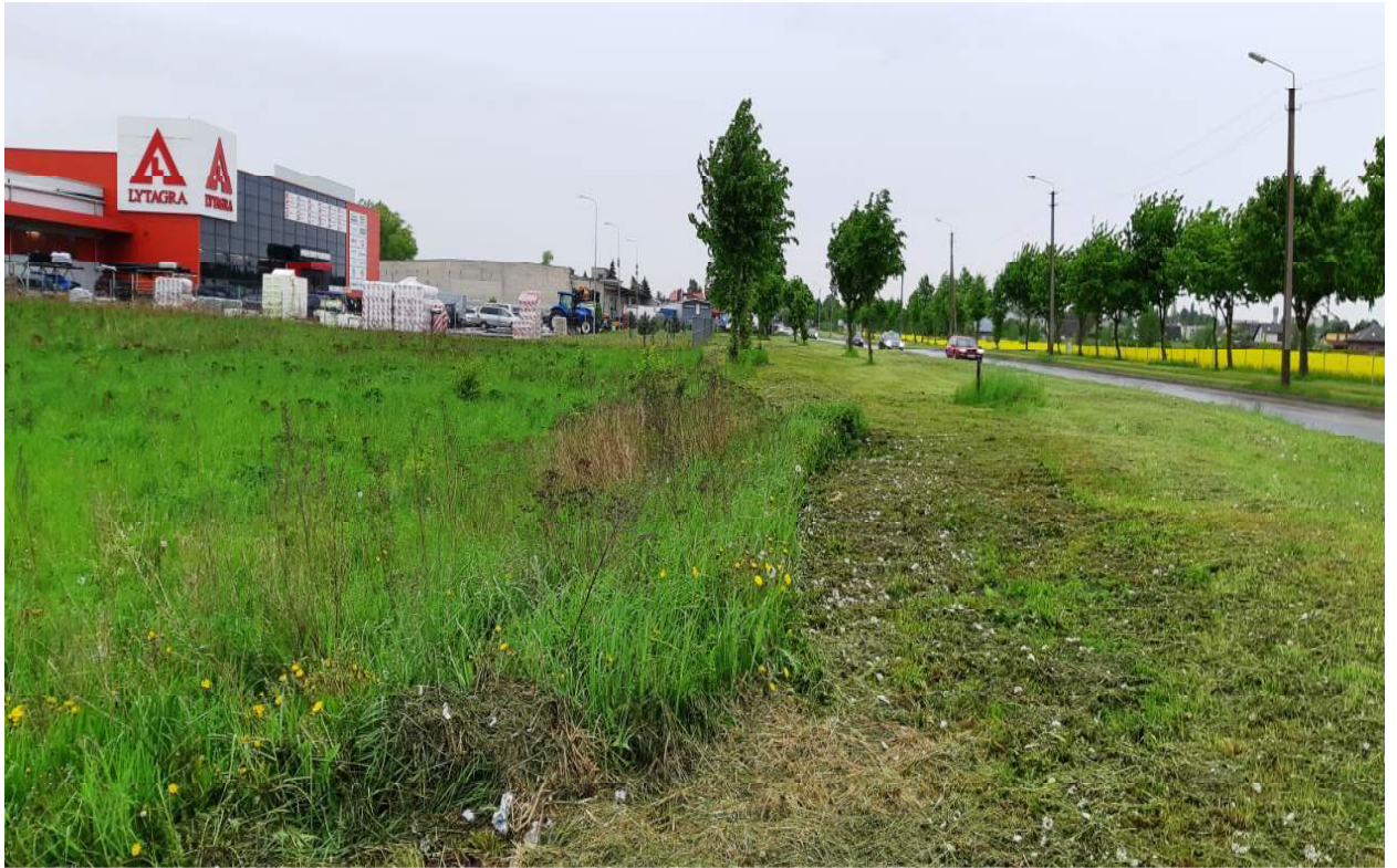
3 pav. Prekybos paskirties pastatas adresu Tiekėjų g. 5 ir Tiekėjų gatvė.
