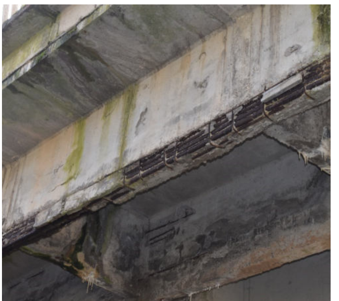
10 pav. Sijose matomos vandens pratakos, betono karbonizacija, atšokęs, nubyrėjęs apsauginis betono sluoksnis, atvira, koroduojanti armatūra. Itin bloga kraštinių sijų būklė, jose dideliais gabalais ištrupėjęs betonas tiek sijos sienutėje, tiek ir lentynose, stipriai korozijos pažeista armatūra
