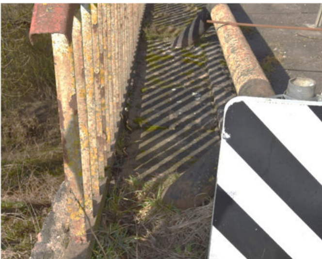
5 pav. Šaltilčių plokščių apsauginis betono sluoksnis aprtrupėjęs, matoma atvira, korduojanti armatūra. Šaltilčių einamoji dalis apaugusi žolėmis, paviršius nusidėvėjęs
