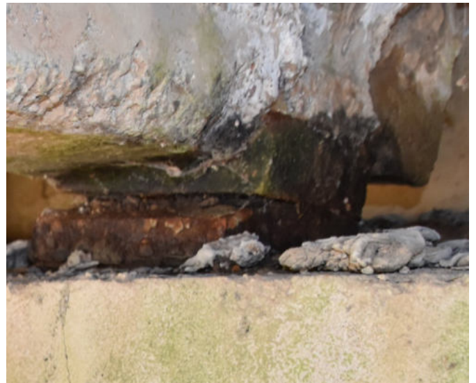
11 pav. Plieniniai atraminiai guoliai pažeisti korozijos
