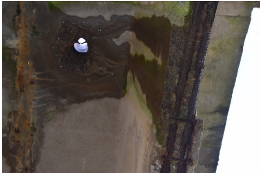
9 pav. Nėra vandens nuvedimo vamzdžių, vanduo pro šulinėlius teka tilto sijomis
