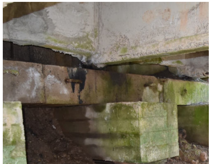
7 pav. Per kiaurus deformacinius pjūvius vanduo teka tilto konstrukcijomis ir jas ardo
