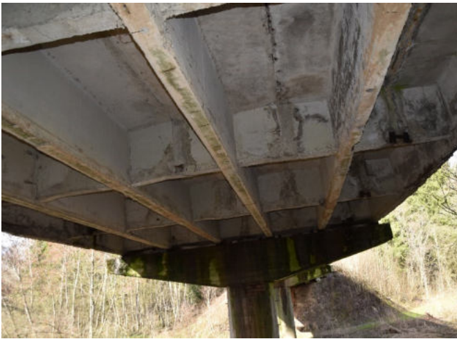
9 pav. Nėra vandens nuvedimo vamzdžių, vanduo pro šulinėlius teka tilto sijomis
