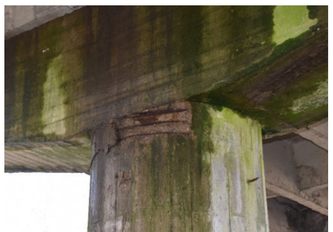
13 pav. Taurai nuolat drėkinami dėl nesandarių deformacinių pjūvių, betonas apkerpėjęs, vietomis atšokęs apsauginis betono sluoksnis, koroduoja armatūra
