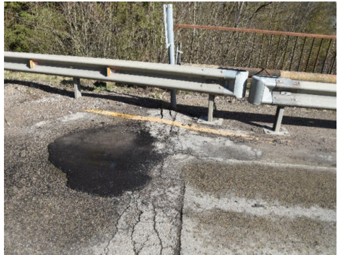
3 pav. Asfalto danga lopyta, vietomis susiformavusios išdauzos, plyšiai ties deformaciniais pjūviais
