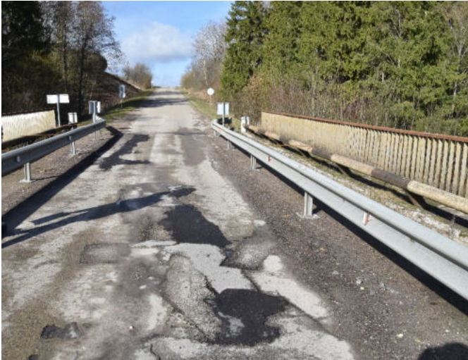
3 pav. Asfalto danga lopyta, vietomis susiformavusios išdauzos, plyšiai ties deformaciniais pjūviais
