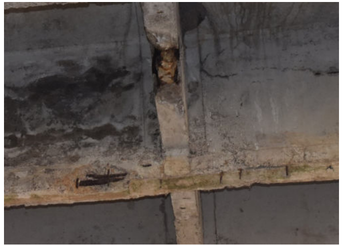
9 pav. Nėra vandens nuvedimo vamzdžių, vanduo pro šulinėlius teka tilto sijomis
