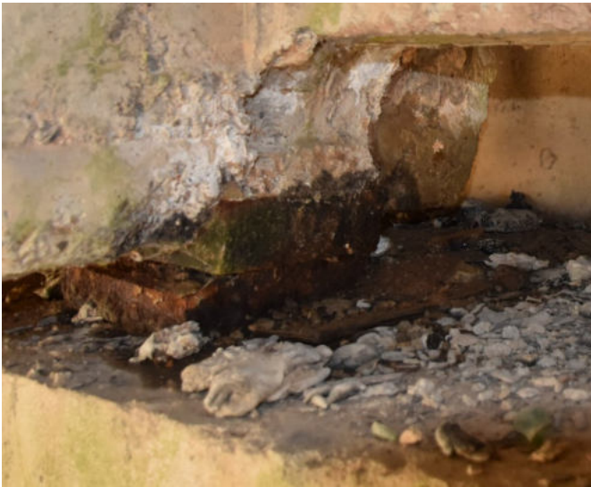
11 pav. Plieniniai atraminiai guoliai pažeisti korozijos
