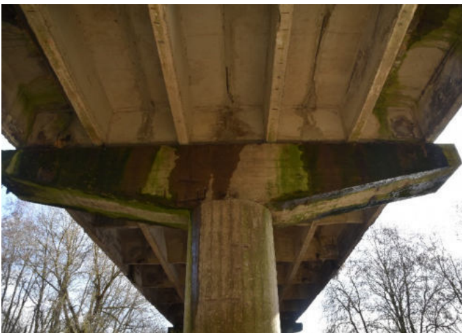
13 pav. Taurai nuolat drėkinami dėl nesandarių deformacinių pjūvių, betonas apkerpėjęs, vietomis atšokęs apsauginis betono sluoksnis, koroduoja armatūra
