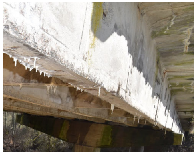
8 pav. Nesandari hidroizoliacija, matomos vandens pratakos, betono karbonizacija
