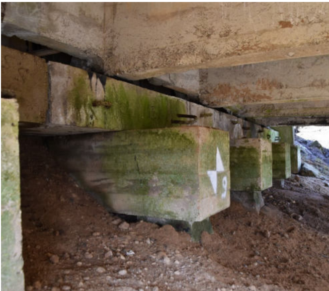
12 pav. Ramtai nuolat drėkinami dėl nesandarių deformacinių pjūvių, betonas apkerpėjęs, vietomis atšokęs apsauginis betono sluoksnis, matomi plyšiai sijų atrėmimo vietose
