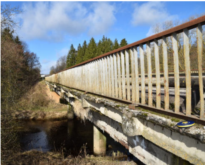
6 pav. Turėklai pažeisti korozijos, vietomis sulankstyti
