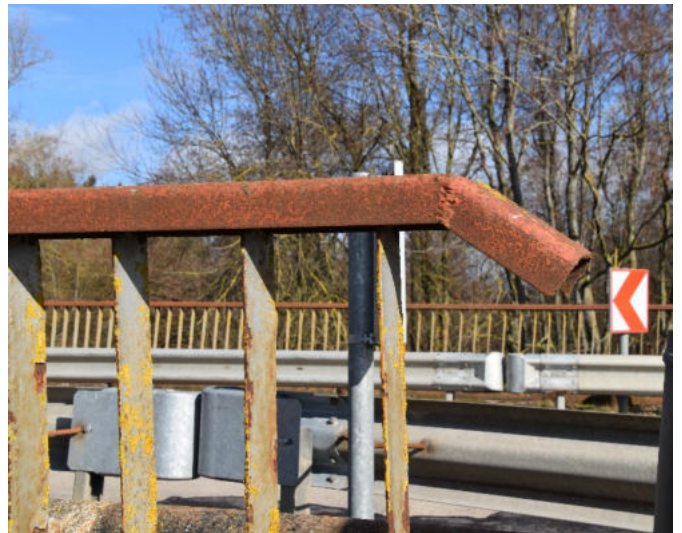
6 pav. Turėklai pažeisti korozijos, vietomis sulankstyti
