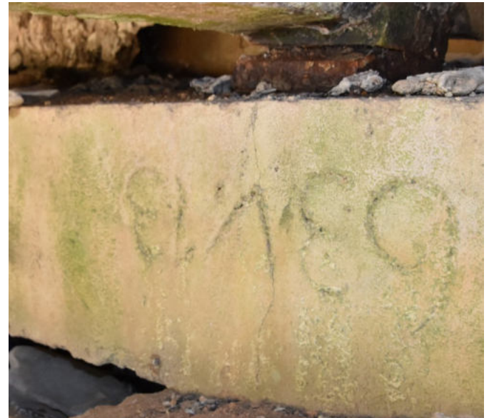
12 pav. Ramtai nuolat drėkinami dėl nesandarių deformacinių pjūvių, betonas apkerpėjęs, vietomis atšokęs apsauginis betono sluoksnis, matomi plyšiai sijų atrėmimo vietose
