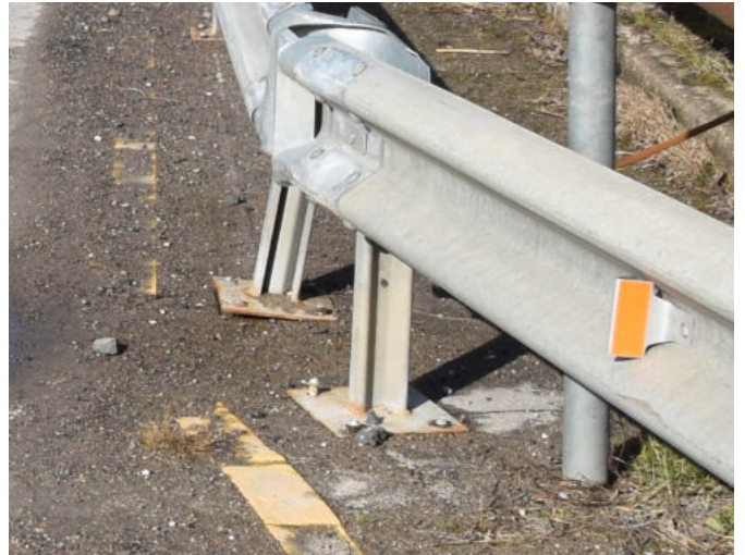
4 pav. Seni metaliniai atitvarai sukorodavę. Naujų metalinių atitvarų, skirtų susiaurinti važiujamąją dalį būklė gera, tačiau vietomis atsilaisvinę jų tvirtinimo varžtai
