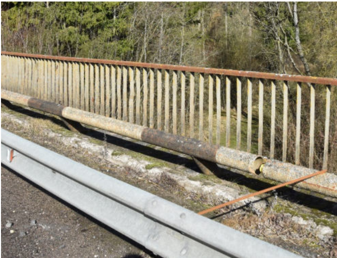
4 pav. Seni metaliniai atitvarai sukorodavę. Naujų metalinių atitvarų, skirtų susiaurinti važiujamąją dalį būklė gera, tačiau vietomis atsilaisvinę jų tvirtinimo varžtai
