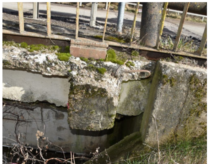
5 pav. Šaltilčių plokščių apsauginis betono sluoksnis aprtrupėjęs, matoma atvira, korduojanti armatūra. Šaltilčių einamoji dalis apaugusi žolėmis, paviršius nusidėvėjęs
