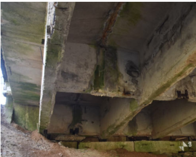
8 pav. Nesandari hidroizoliacija, matomos vandens pratakos, betono karbonizacija
