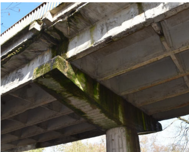
7 pav. Per kiaurus deformacinius pjūvius vanduo teka tilto konstrukcijomis ir jas ardo
