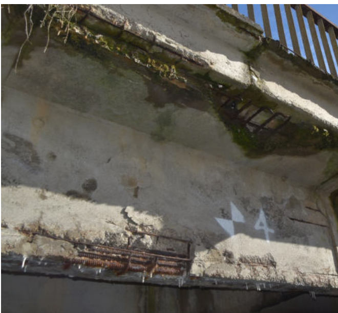
10 pav. Sijose matomos vandens pratakos, betono karbonizacija, atšokęs, nubyrėjęs apsauginis betono sluoksnis, atvira, koroduojanti armatūra. Itin bloga kraštinių sijų būklė, jose dideliais gabalais ištrupėjęs betonas tiek sijos sienutėje, tiek ir lentynose, stipriai korozijos pažeista armatūra
