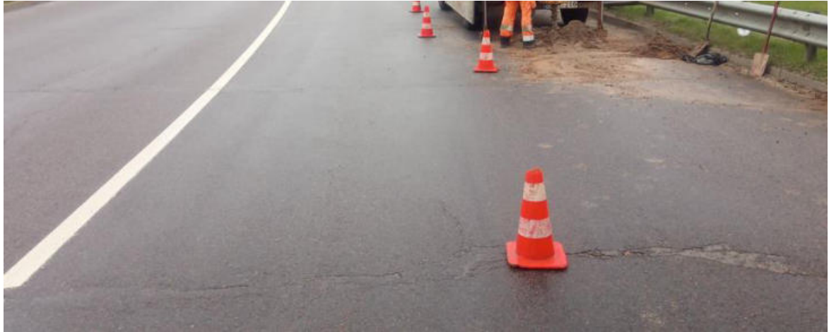
4 pav. Įtrūkimai ir ištrupėjimai ant viaduko, ties Gr.SZ-2
