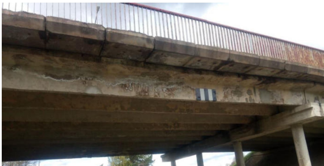
6 pav. Viaduko kraštinė sija rytinėje pusėje
