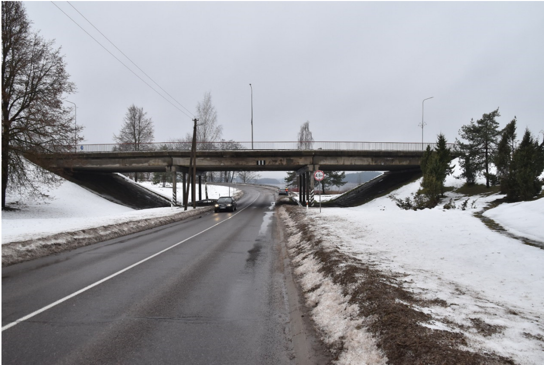
2 pav. Viaduko A6 kelio 180,301 km per 102 kelią fasadinis vaizdas
