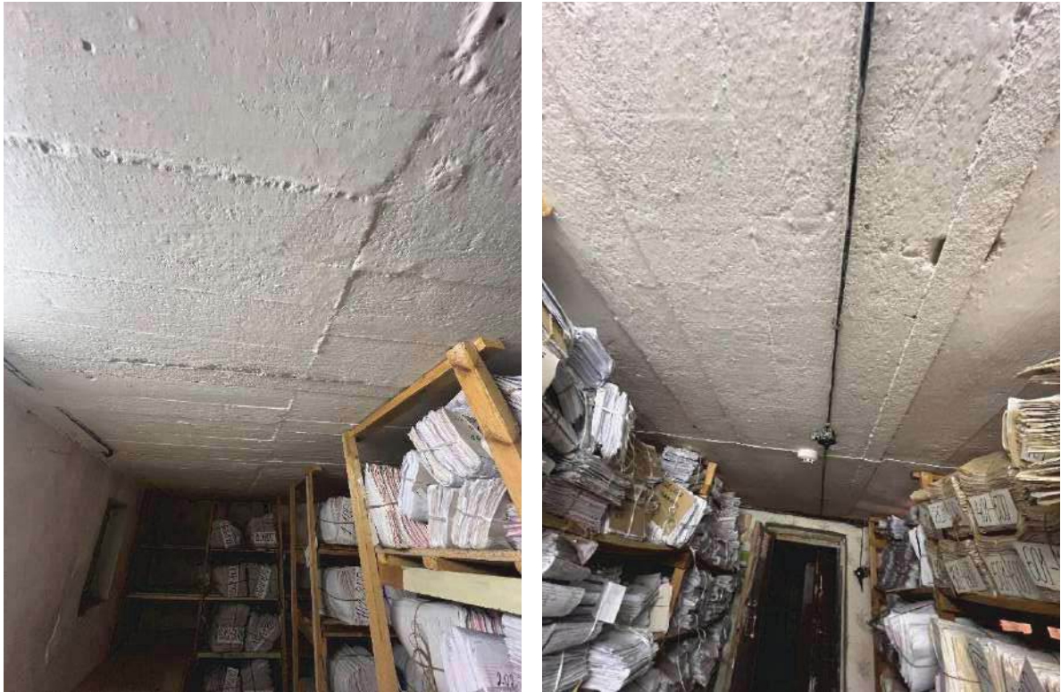
10, 11 pav. Rūsio patalpų fotofiksacija
