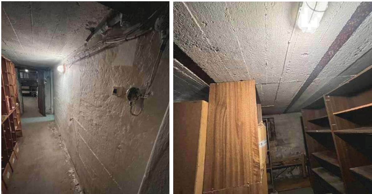
12, 13 pav. Rūsio patalpų fotofiksacija
