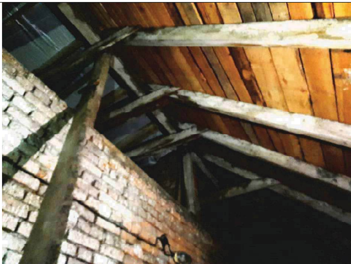
Nr. 12 Pavadinimas Pastogės medinės gegninės konstrukcijos fragmentas
