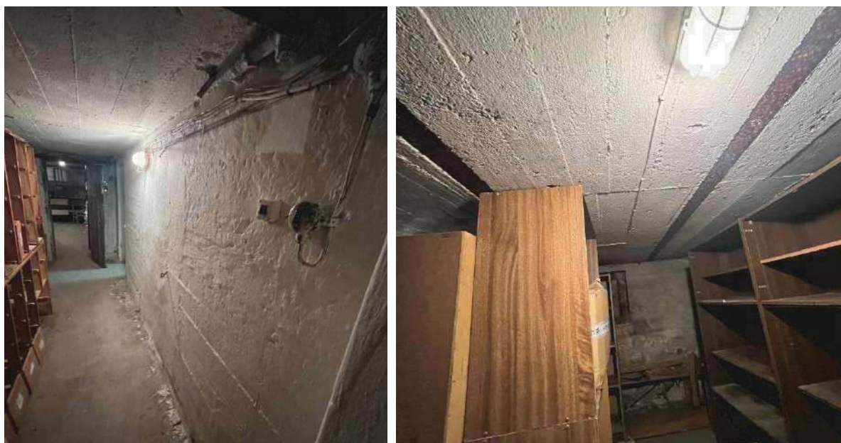
7, 8, pav. Rūsio patalpų fotografacija
