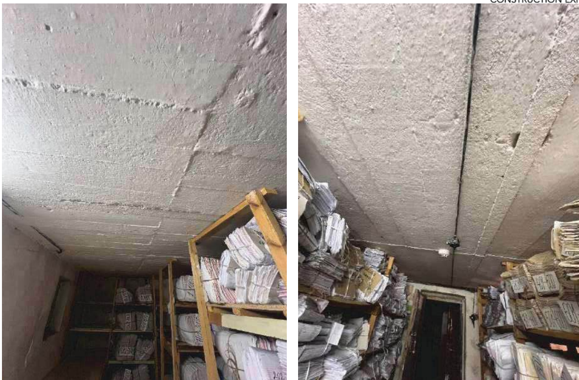
5, 6 pav. Rūsio patalpų fotografacija
