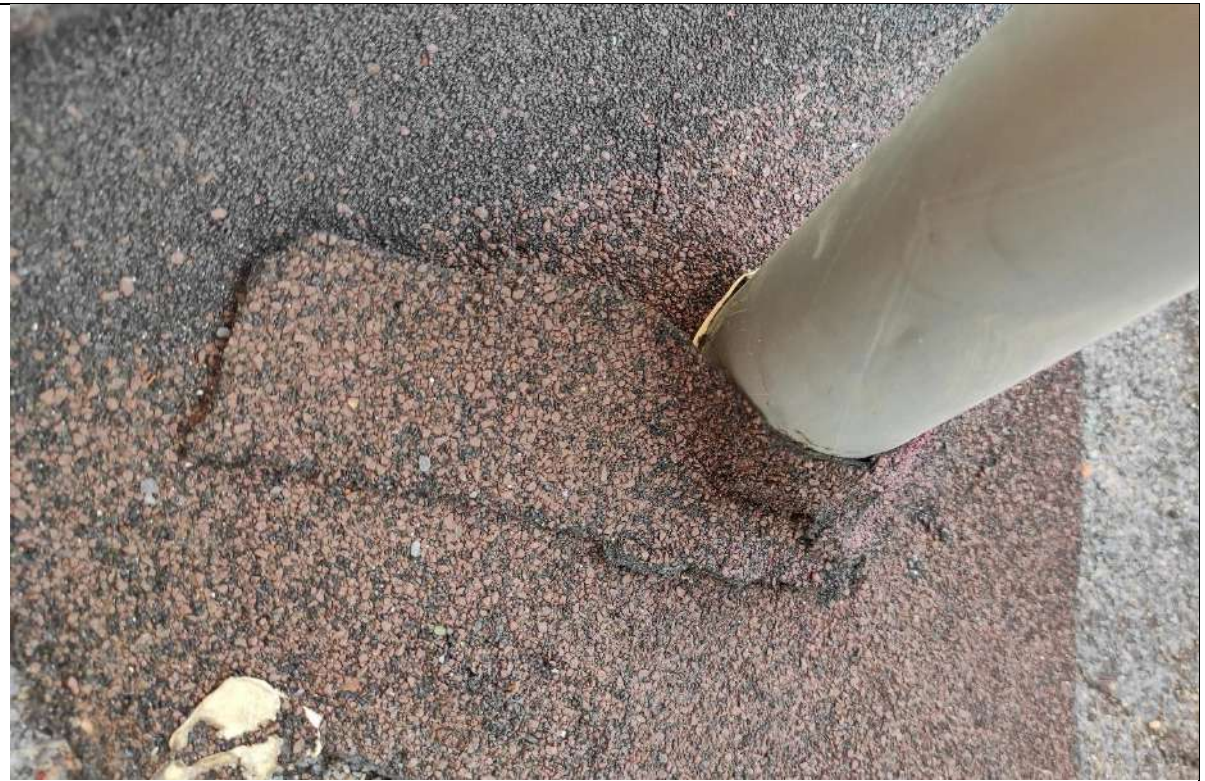
93. Vaizdas iš arti. Netinkamai užsandarintas kondicionieriaus vamzdis.
