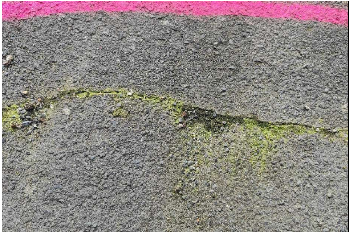
73. Vaizdas iš arti. Įtrūkusi stogo danga.
