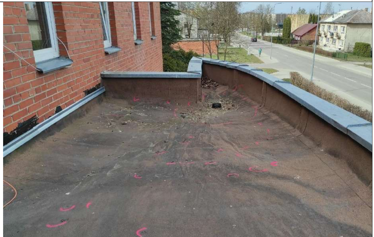
60. Stogo danga nusidėvėjusi, pažeista, sutrūkinėjusi, pažeista augmenijos.
