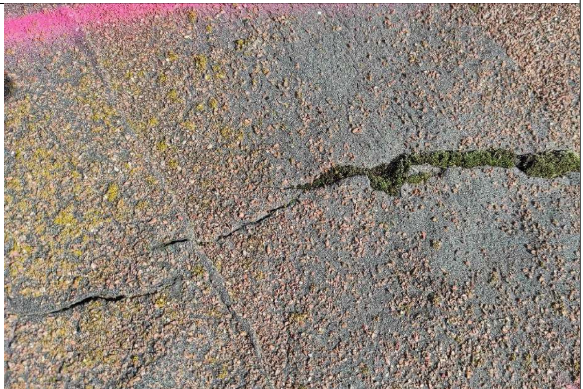
23. Vaizdas iš arti. Daug stogo dangos įtrūkimu ir pažeidimų.
