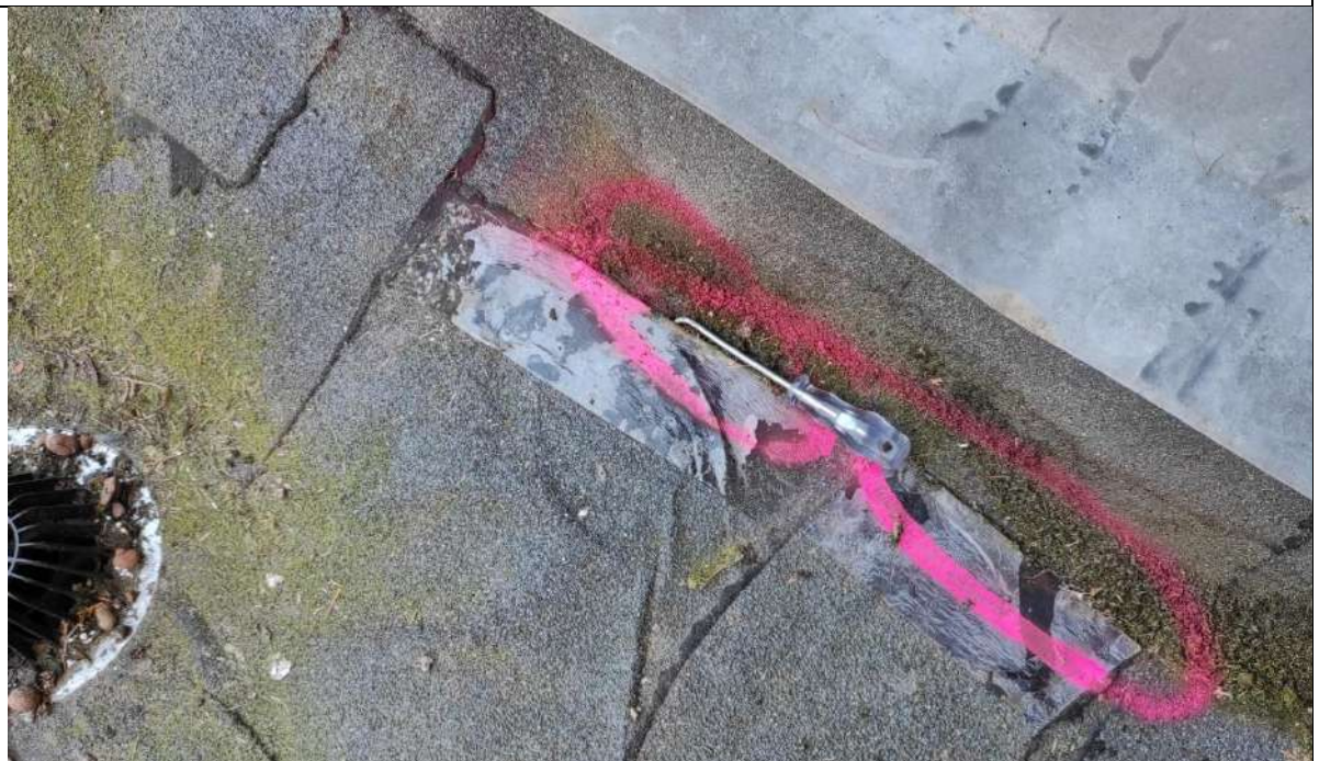
98. Nesandari sulydymo siūlė. Paliktas nepašalintas dangos kraštas skirtas sulydymo siūlėms įrengti.
