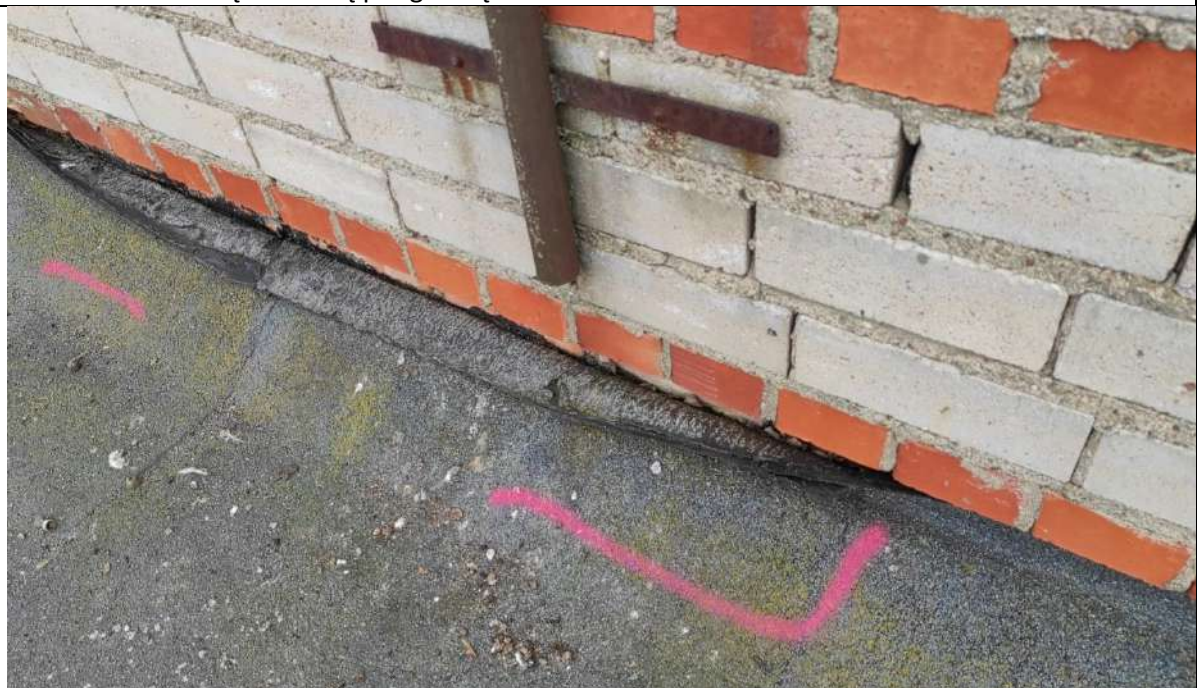
47. Atšokusi stogo danga nuo parapeto vertikaliuos plokštumos, nesandarumai prie įlajos, nėra sumontuotų skardinių prieglaudų.
