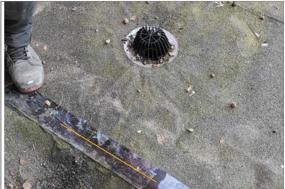
103. Palikta nenupjauta sulydymo siūlės juosta.
