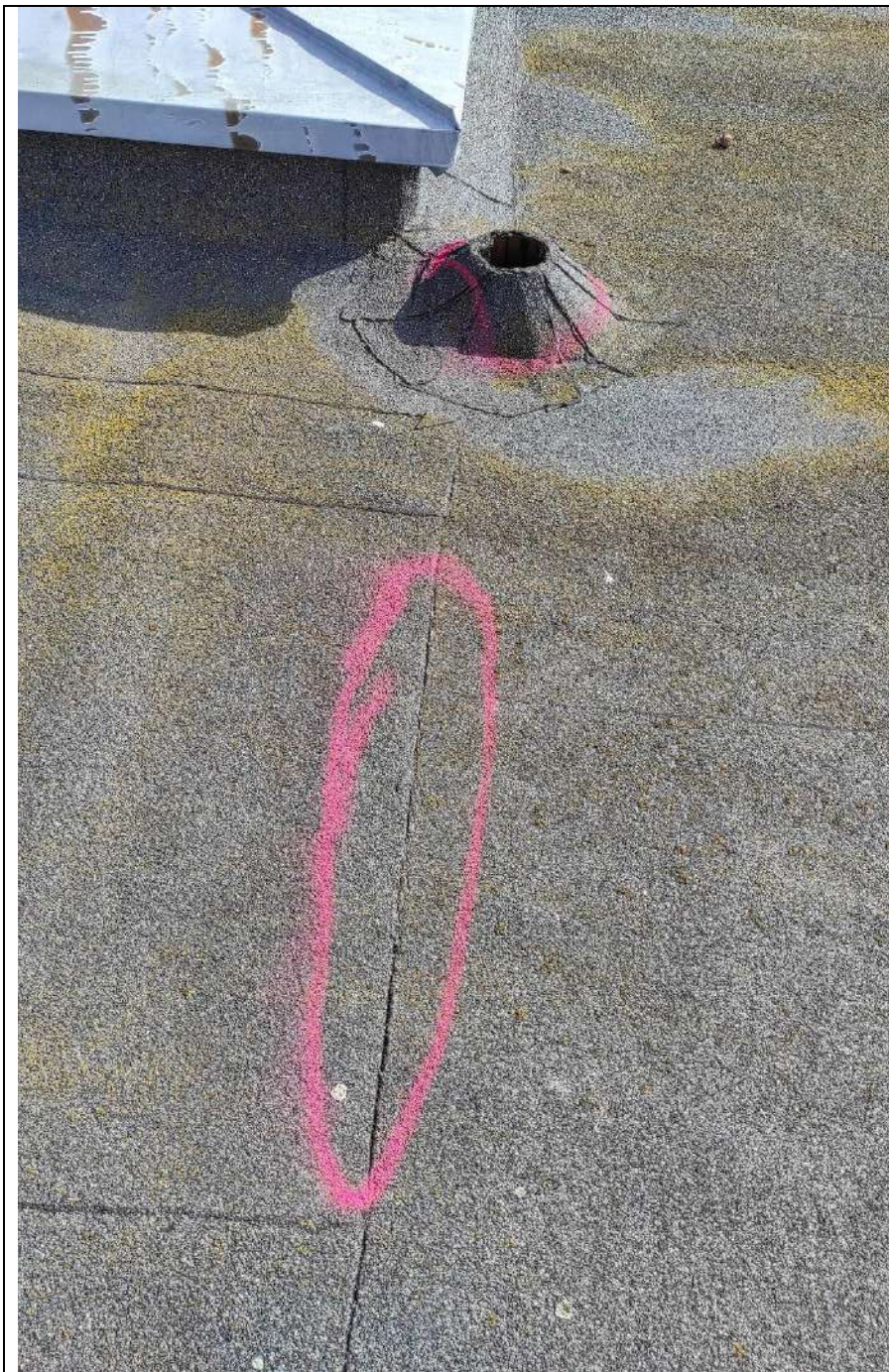
42. Vaizdas iš arti . Stogo dangos įtrūkimas sulydymo linijoje.
