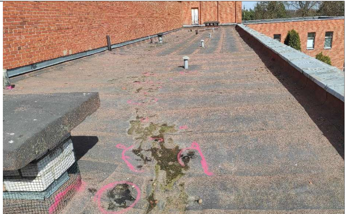
11. Atskirose vietose net nėra viršutinio stogo dangos sluoksnio, danga išplėšyta, apsauginis dangos pabarstas nubyrėjęs.
