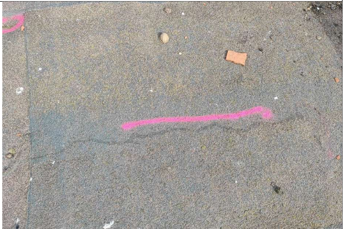
18. Vaizdas iš arti. Įtrūkusi stogo danga.
