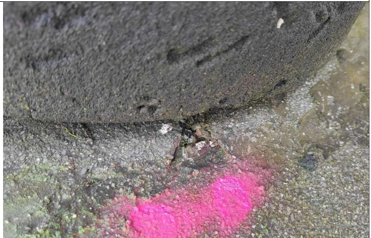
57. Vaizdas iš arti. Per siūlę iš po dangos skverbiasi drėgmė.
