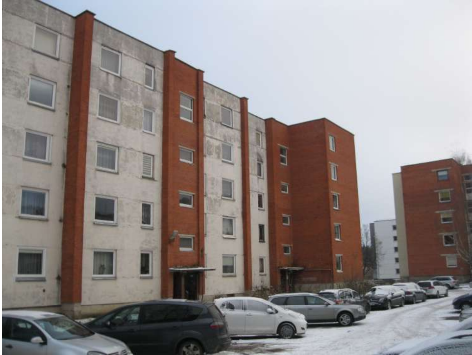
1 pav. Pagrindinio šiaurinio pastato fasado bendras vaizdas. Visi šio fasado langai pakeisti į naujus plastikinius langus. Pastebėti žymūs fasado apdailos pažeidimai, kurie labai gadina bendrą pastato vaizdą.
