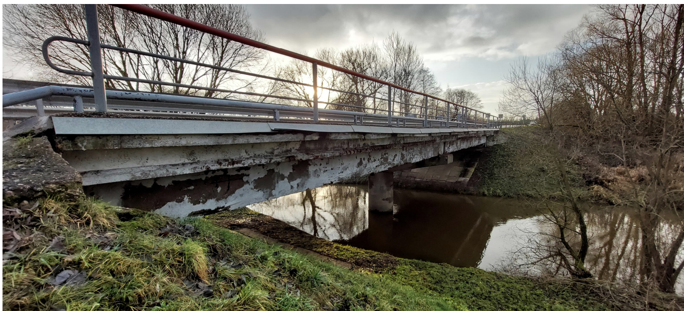
1 pav. Esamo tilto vaizdas
