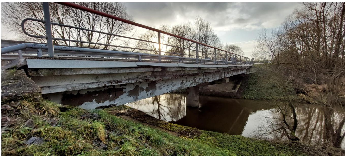
1 pav. Esamo tilto vaizdas
