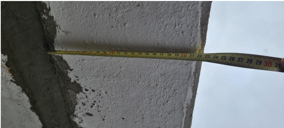
Nuotrauka Nr. 5 Fasadinių dujų silikato plokščių storis 225 mm
