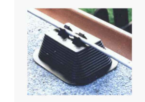
Laidininko d-8mm. montavimas ant pastato stogo dangos
