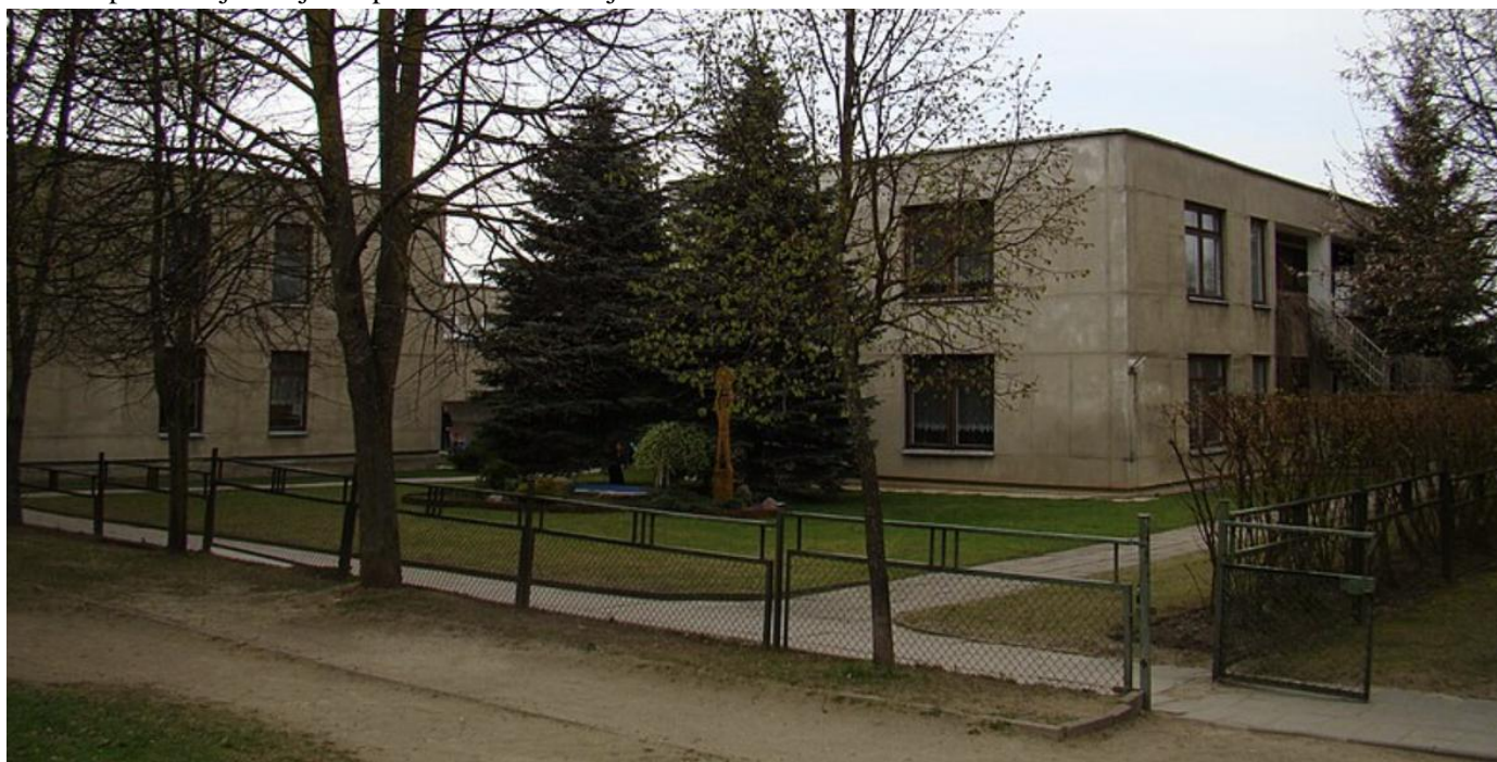
2 pav. Esamas dviejų aukštų darželio pastatas
