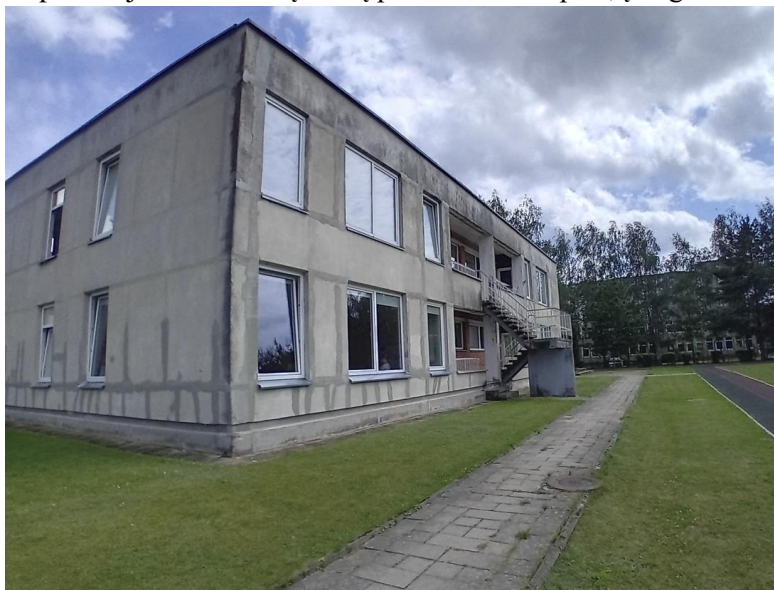
6 pav. Išėjimas iš antro aukšto balkono 3 tipo išoriniais laiptais, kurie bus nugriauti. Projekte vietoje balkono bus įrengiamos personalui patalpos. Perprojektuojami 3 tipo išoriniai laiptai naujai, uždengiami laidžiomis orui lamelėmis.
