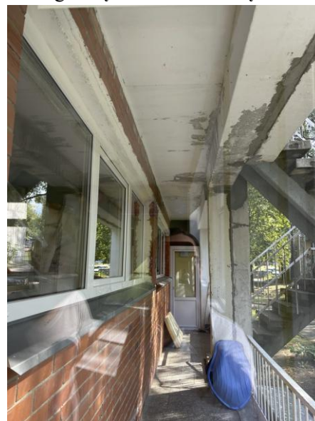
6 pav. Išėjimas iš antro aukšto balkono 3 tipo išoriniais laiptais, kurie bus nugriauti. Projekte vietoje balkono bus įrengiamos personalui patalpos. Perprojektuojami 3 tipo išoriniai laiptai naujai, uždengiami laidžiomis orui lamelėmis.
