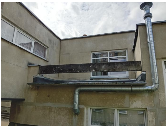
3 pav. Vėdinimo įrenginiai bus keičiami naujais. Esami sprendiniai neatitinka keliamų reikalavimų.
