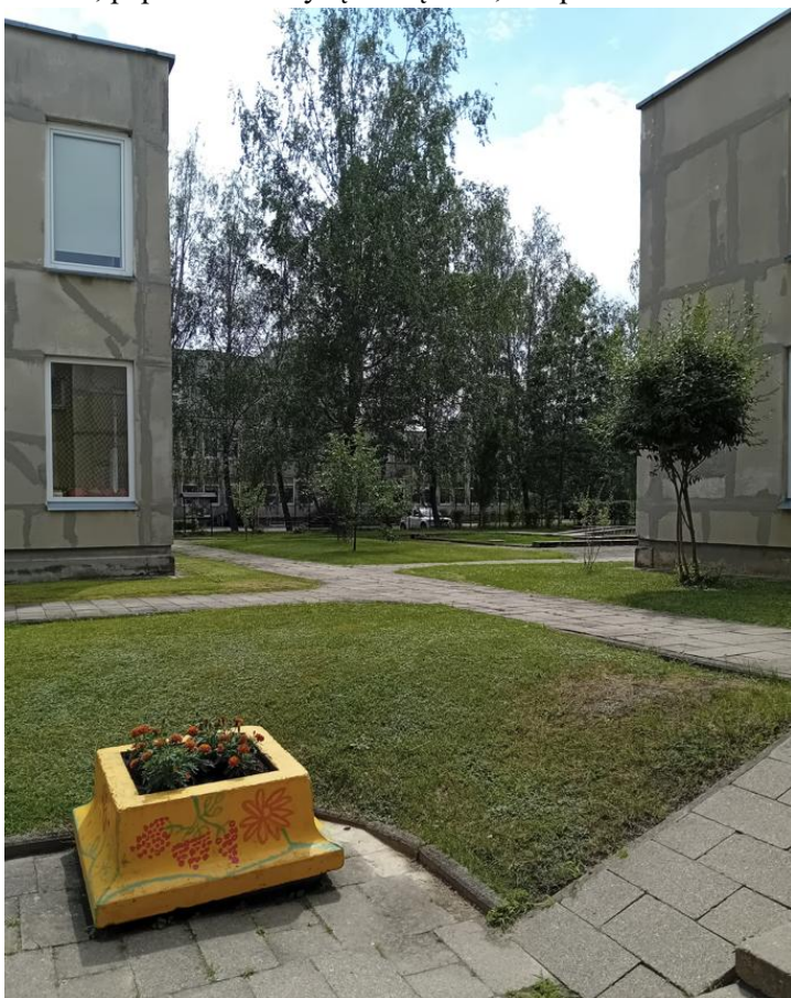
8. Tarp pačių korpusų yra didesnia, kaip 6 m atstumas, neskaitant atskirtų priešgaisrinėmis sienomis L1 tipo laiptinių, kurios veda į vidinį kiemą. Vidinis kiemas turi reljefo perkritimą žemyn.
