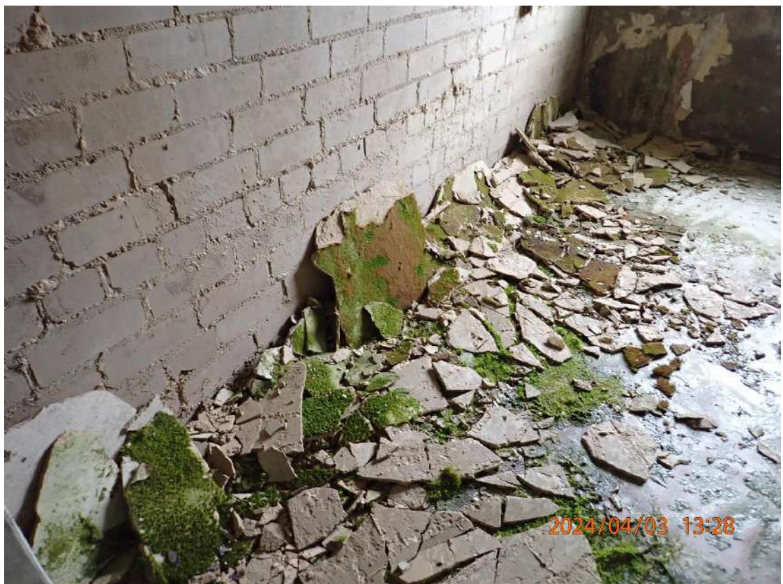
Nuotrauka Nr. 10. Dėl drėgmės poveikio atšokęs laikančių sienų tinkas. Mūras patenkinamos būklės
