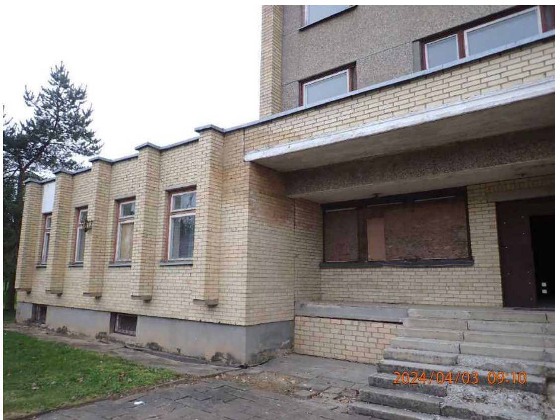
Nuotrauka Nr. 1. Nesutvarkyti rūšio langai, nuogrinda, sutręšę langų rėmai arba jų nebėra
