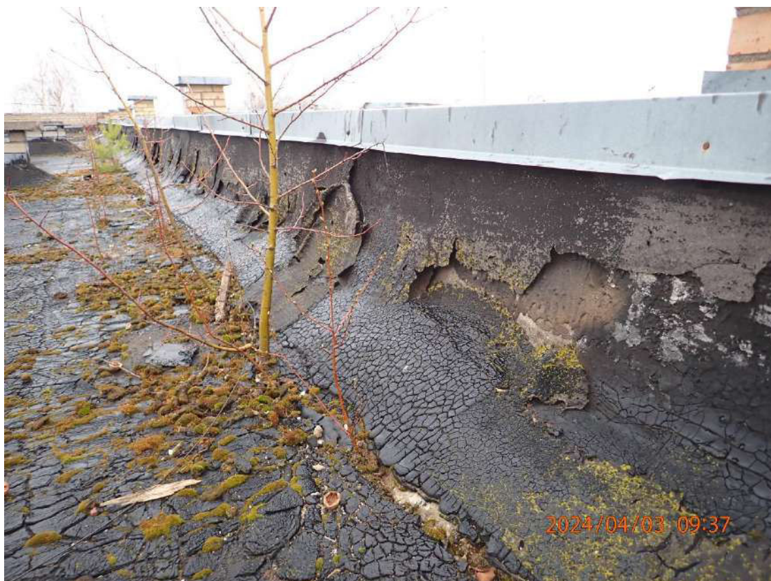
Nuotrauka Nr. 19. Ant stogo auga medžiai, ardo stogo dangą ir pasluoksnius. Stogo hidroizoliacijos vietomis iš viso nėra
