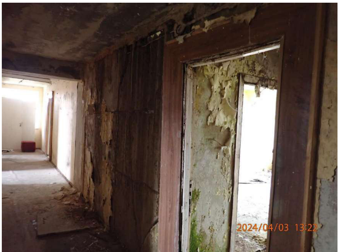
Nuotrauka Nr. 12. Vidaus durys pažeisto puvinio, dalies varčių trūksta.
