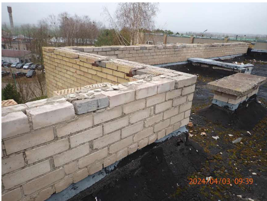
Nuotrauka Nr. 20. Suirusi stogo danga, trūksta dalies parapeto apskardinimo
