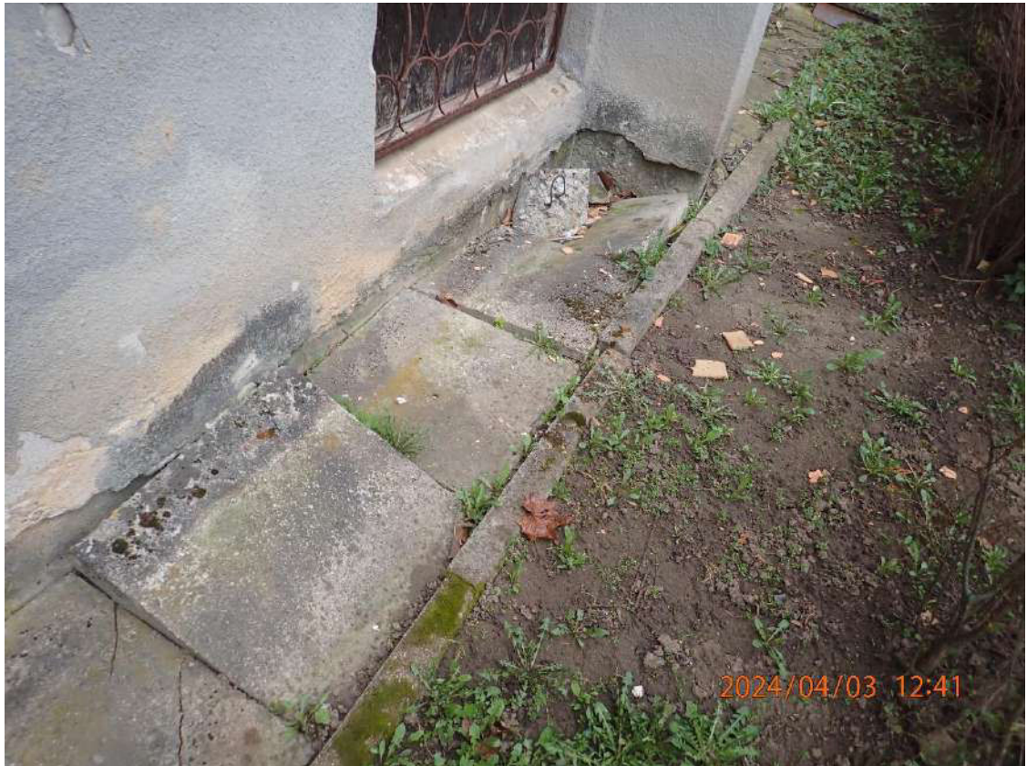
Nuotrauka Nr. 3. Pažeista nuogrinda, drėksta siena, trupa tinkas
