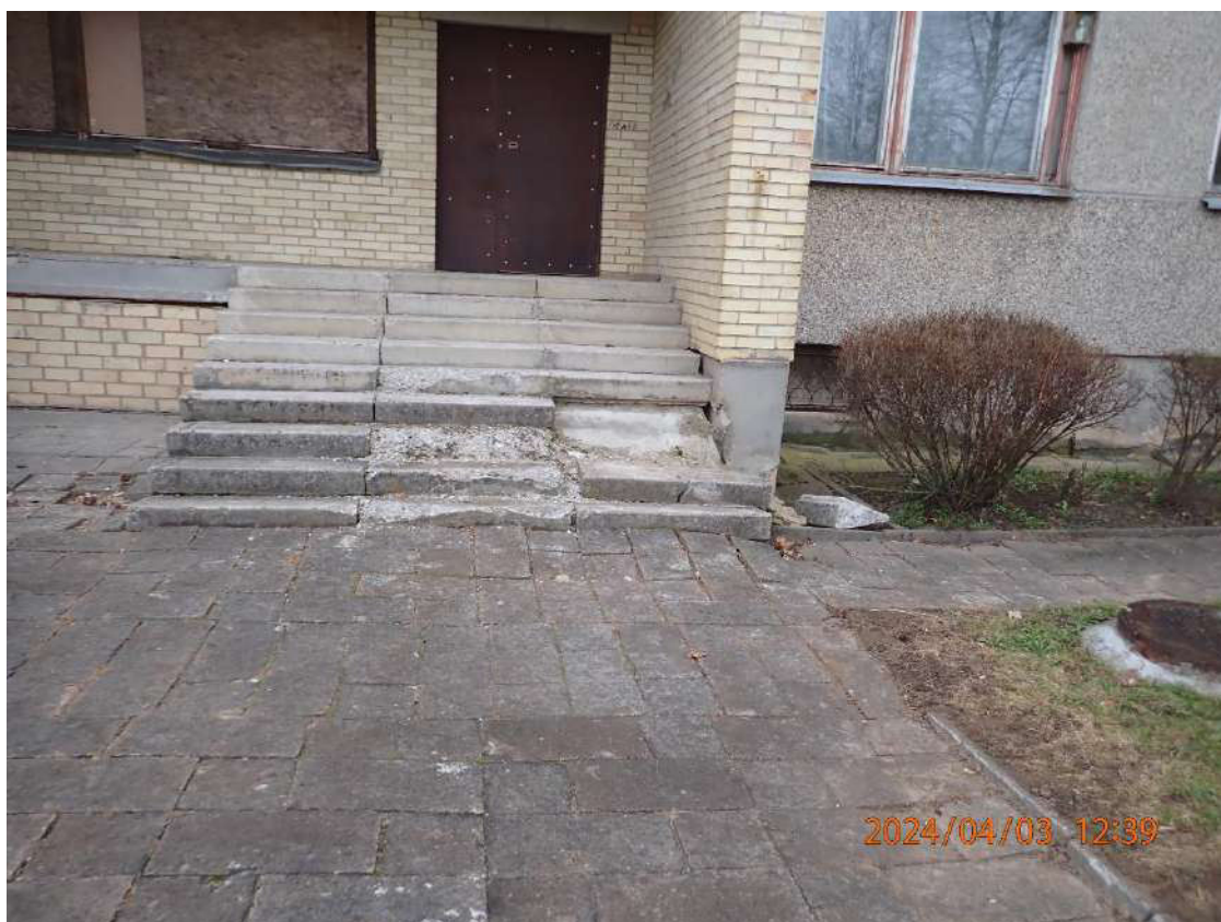
Nuotrauka Nr. 2. Nesandarios durys, pavojingai suyrę įėjimo lauko laiptai, nuimti apsauginiai tūrėklai, sutręšę mediniai langų rėmai
