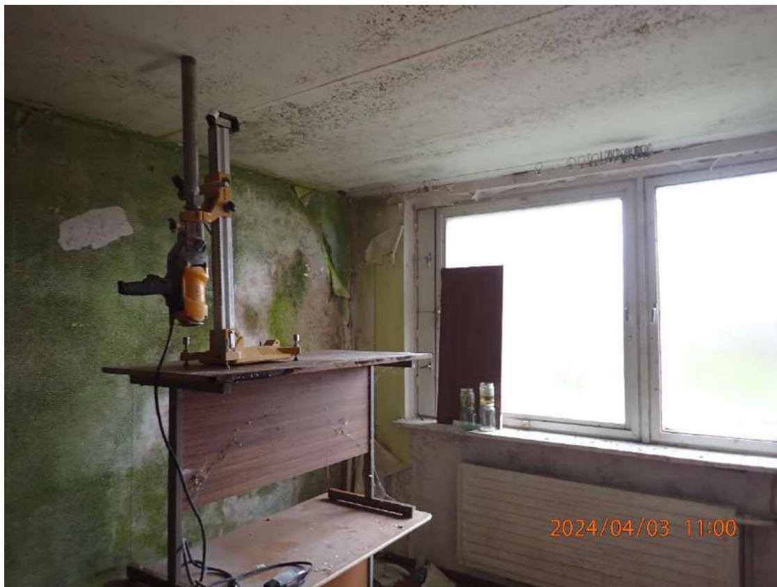
Nuotrauka Nr. 27. Betono kernų (ėminių) paėmimas tyrimams perdangos plokštėje
