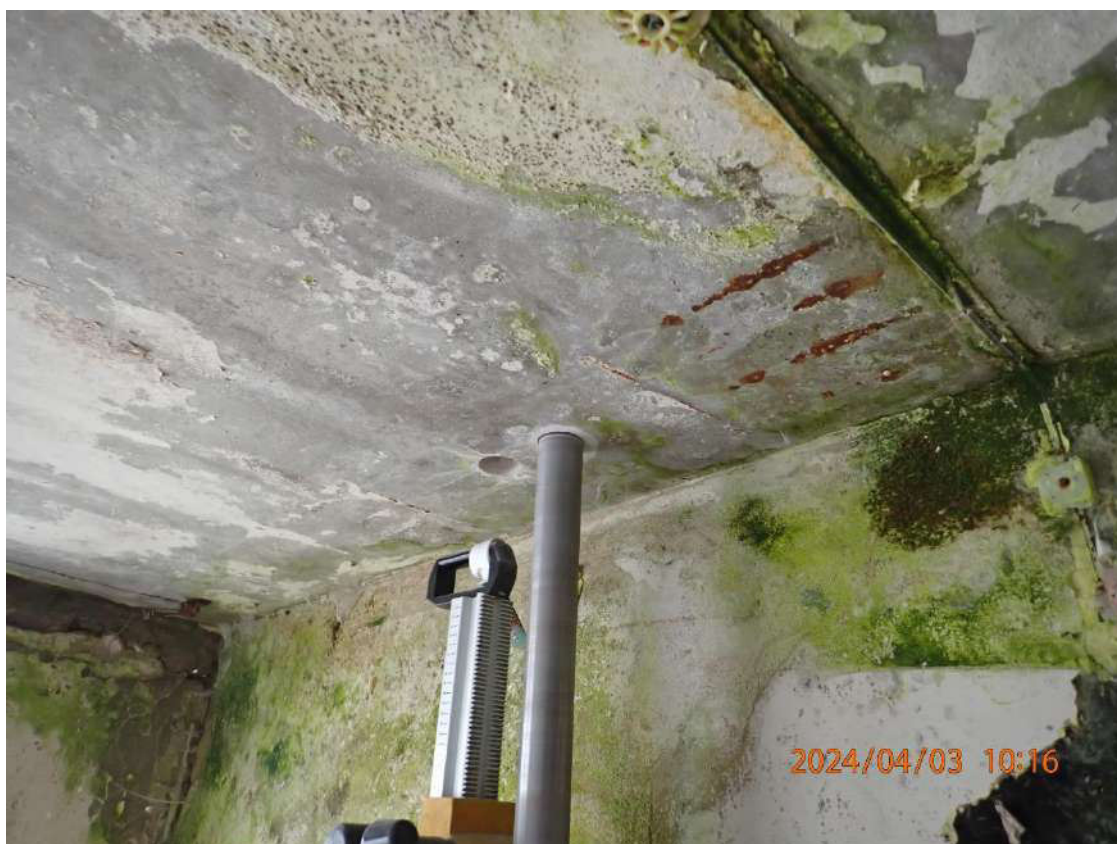
Nuotrauka Nr. 22. Betono kernų (ėminių) paėmimas tyrimams denginio plokštėje
