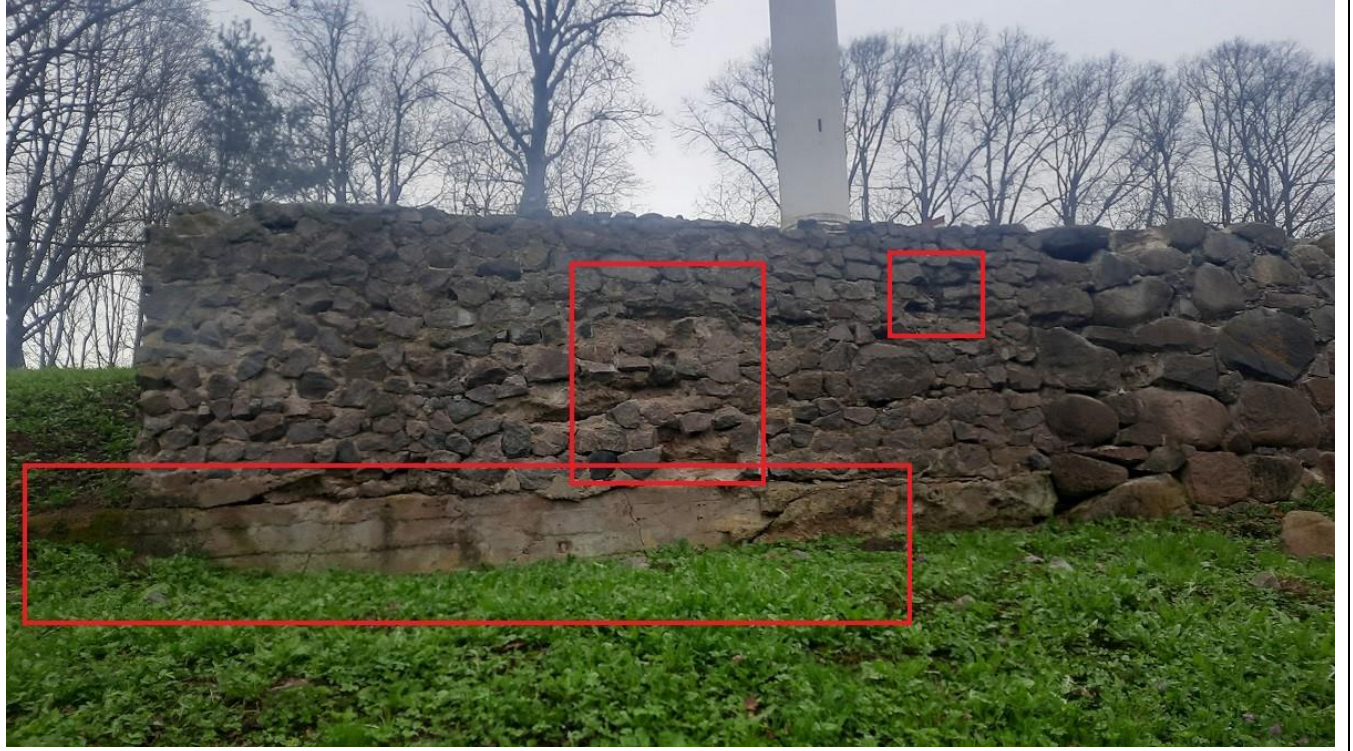
Šiaurinės atraminės sienelės-pamato fragmentas. Skilusi atraminė sienelė sėda žemyn skardžio link. Pamato akmenų mūre gausu plyšių. Vietomis išbyrėję akmenys. Atvirai matoma pamato betoninė konstrukcija. Data: 2023-04-01
