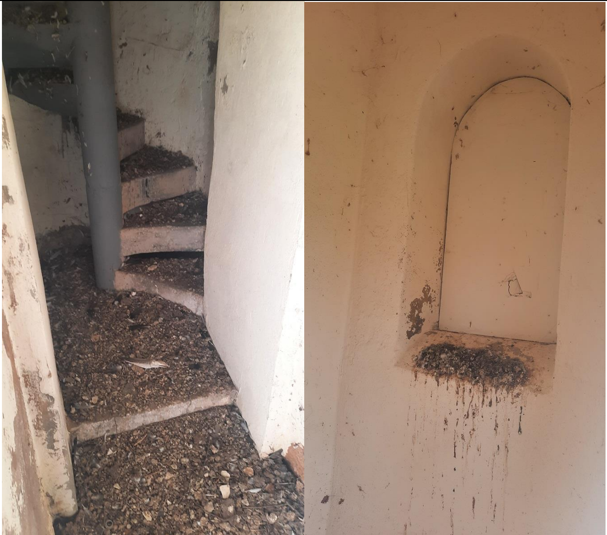
Minaretas. Anga tarp tambūro ir bokšto patalpų. Data: 2023-04-01
