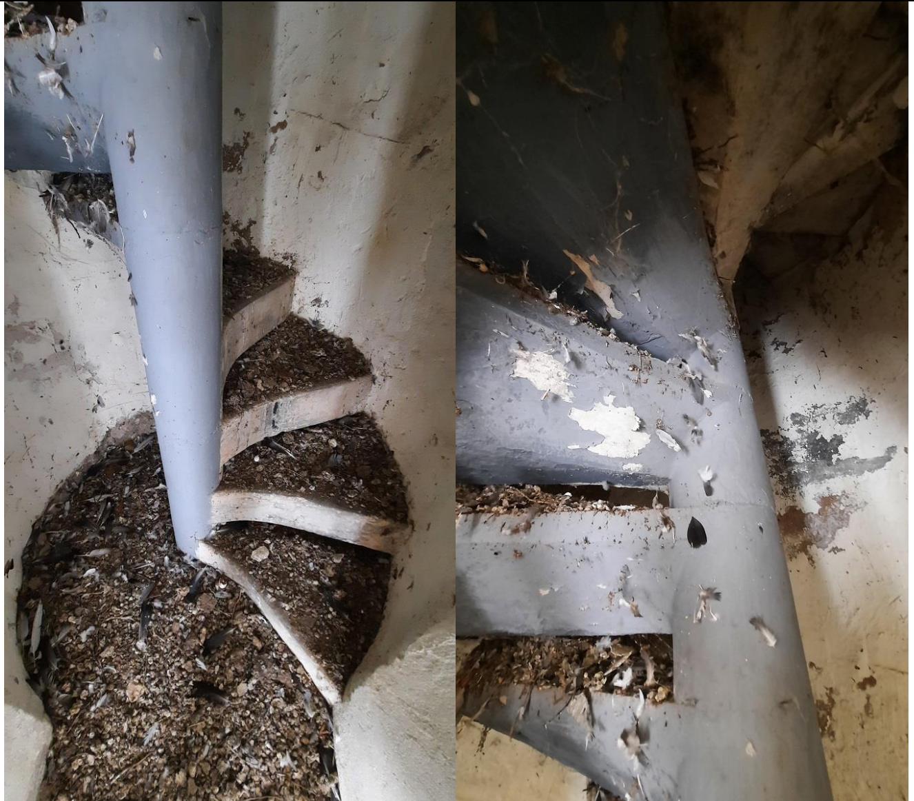
Minareto bokšto laiptų aikštelės fragmentas. Minarete gausu paukščių liekanų ir jų išmatų. Didelė smarvė įsigėrusi į sienų ir laiptų konstrukciją. Šiuo metu užlipimas į bokšto viršų nėra galimas. Būtinai vidaus patalpų valymas ir dizinfekavimas. Angų sandarinimas.
