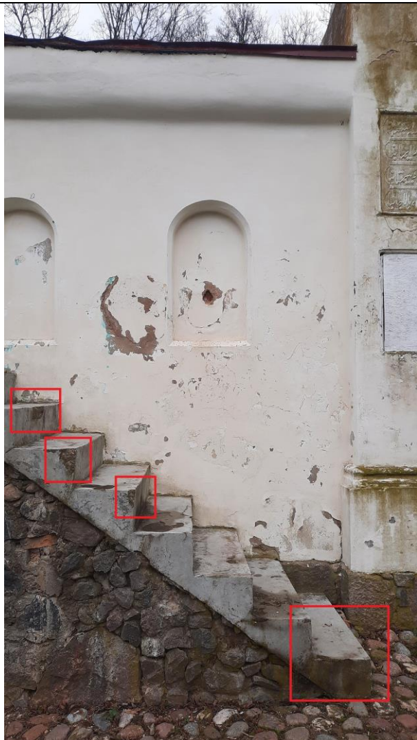
Pavadinimas: Minaretas. Žemutinė dalis. Vaizdas iš V fasado. Nutrupėjęs laiptų pakopų betonai. Būtini betono atnaujinimo darbai.
