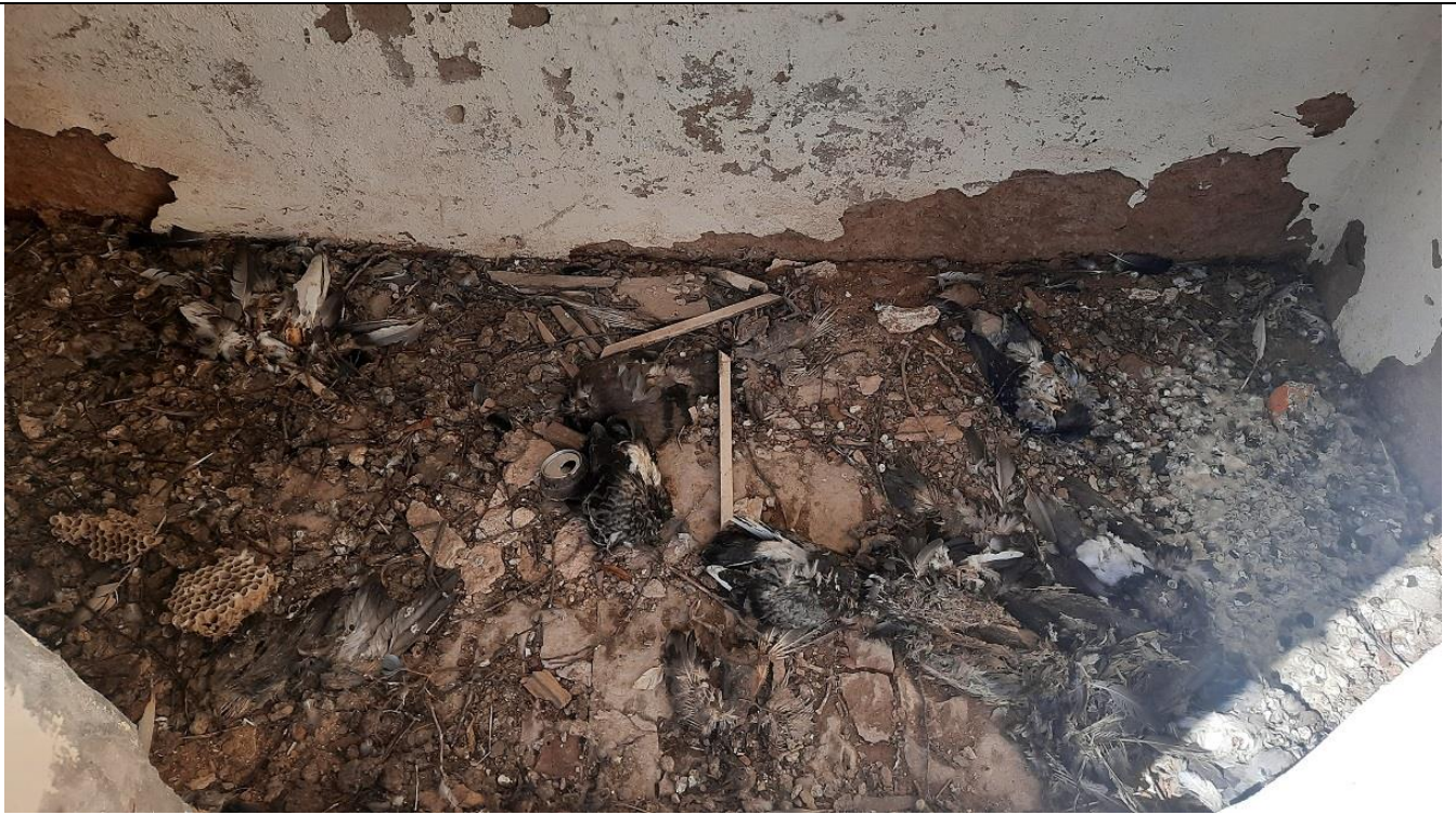
Minaretas. Anga tarp tambūro ir bokšto patalpų. Data: 2023-04-01
