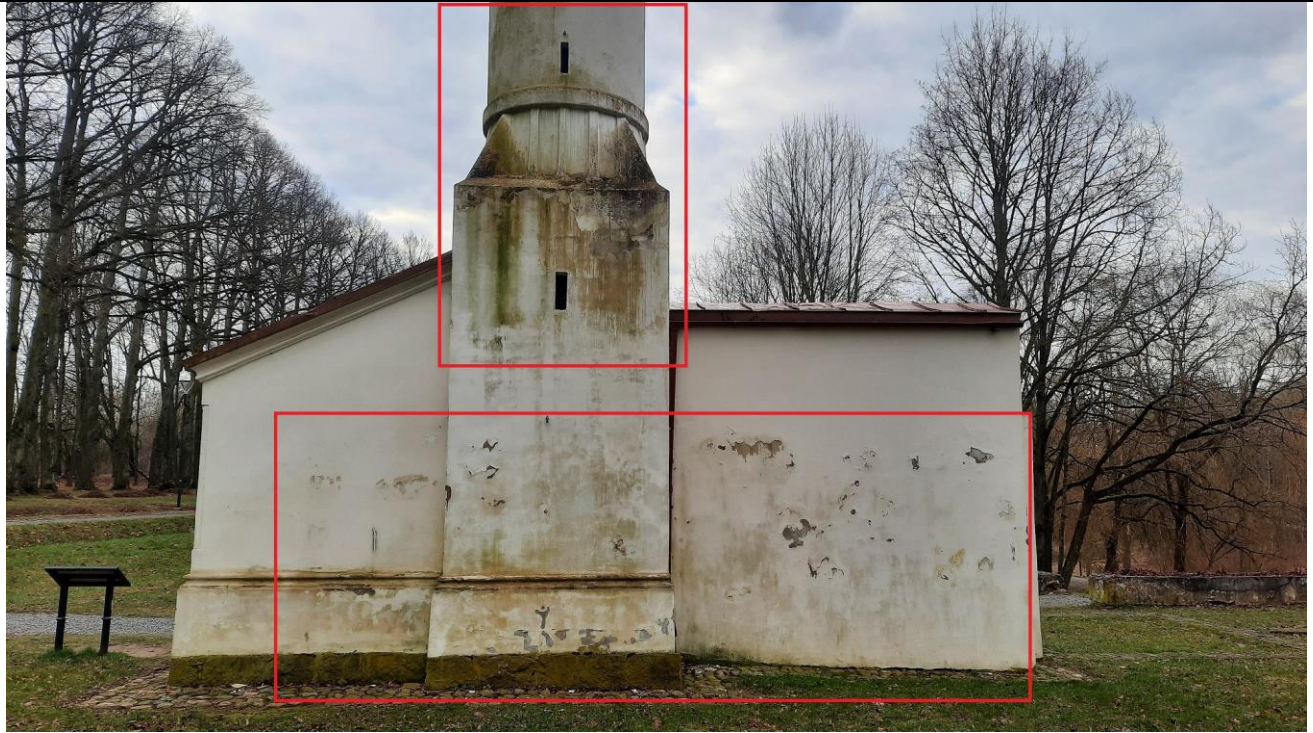
Pavadinimas: Minaretas. Žemutinė dalis. Š fasadas. Stipriai pažaliavęs pamato cokolis ir pirmo tarpsnio š pusės fasado dalis ties bokšto pradžia. Matomi gausūs tinko sluoksnio ir dažų paviršiniai pažeidimai.
