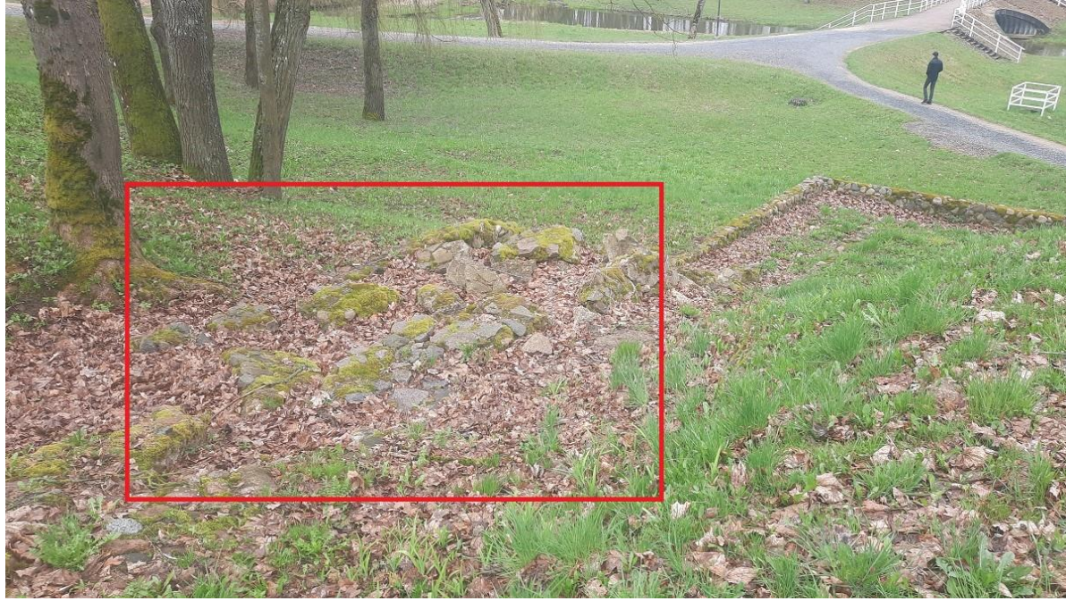
Atraminės sienlės fragmentas P dalyje. Vietomis mėtosi palaidi ir betono surišti akmenų gabalai. Data: 2023-04-01
