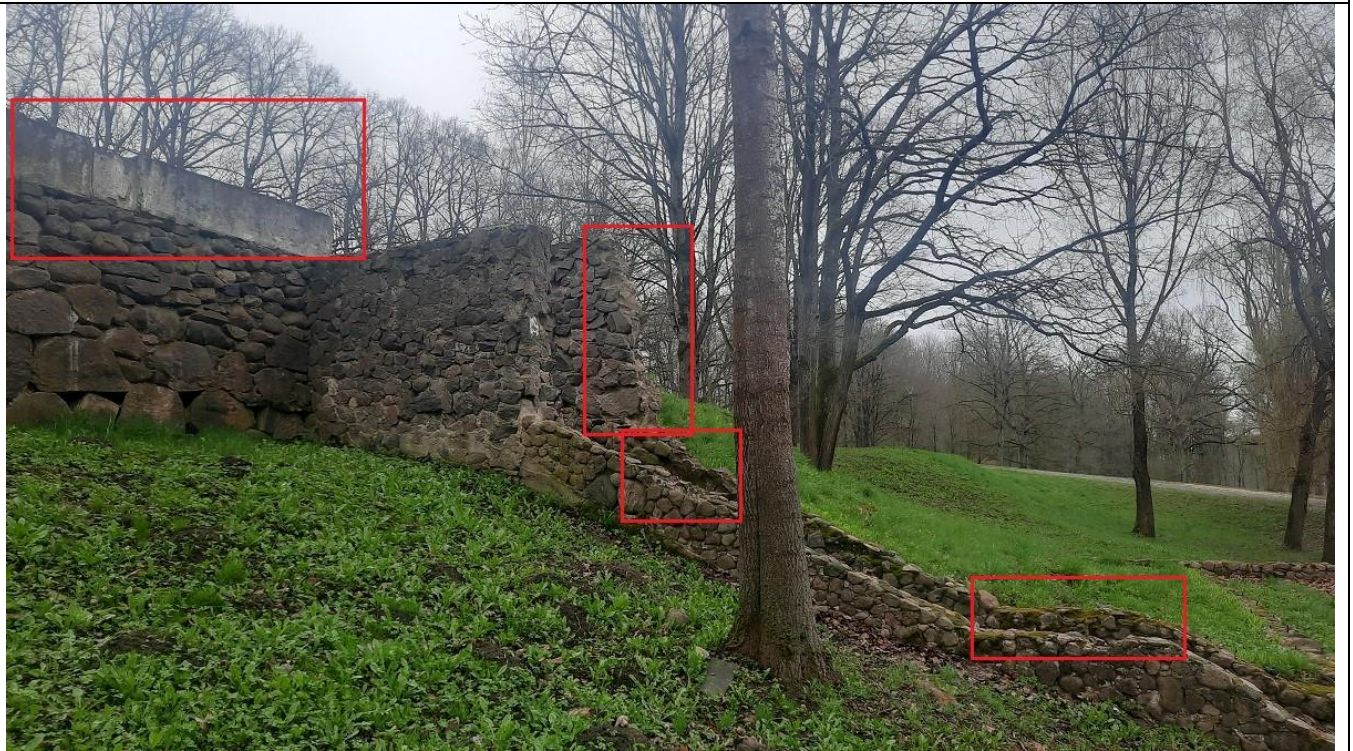
Laiptų-atraminės sienelės fragmentas. Atraminės sienelės pietinėje dalyje gausus akmenų riedulių nutrupėjimas. Data: 2023-04-01
