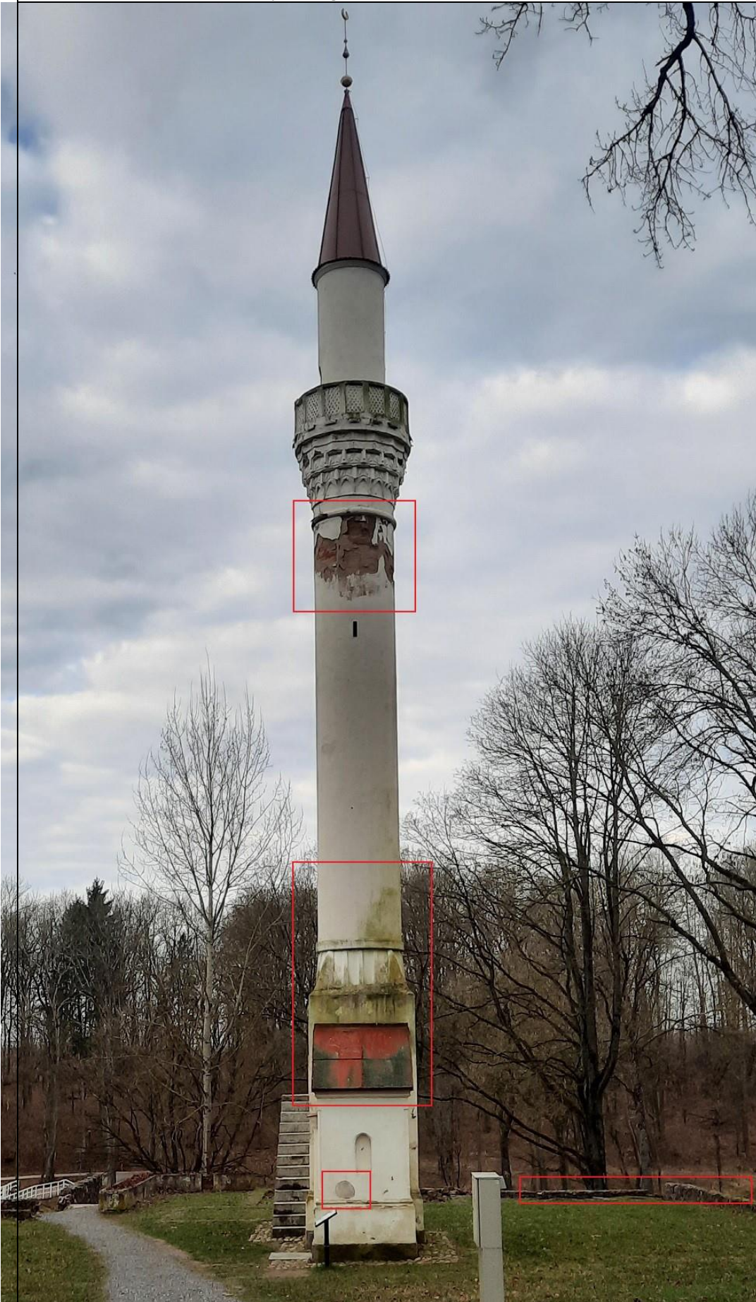
Pavadinimas: Minaretas. Š fasadas. Smarkiai nutrupėjęs bokšto viršaus šiaurinės dalies sienos tinko sluoksnis. Vietomis atviros plytos, kas kelia grėsmę tolimesniam sienos mūro laikančiųjų savybių praradimui. Vietomis nutrupėjęs tinkas nuo ažūrinės balkono tvorelės . Data: 2023-04-01
