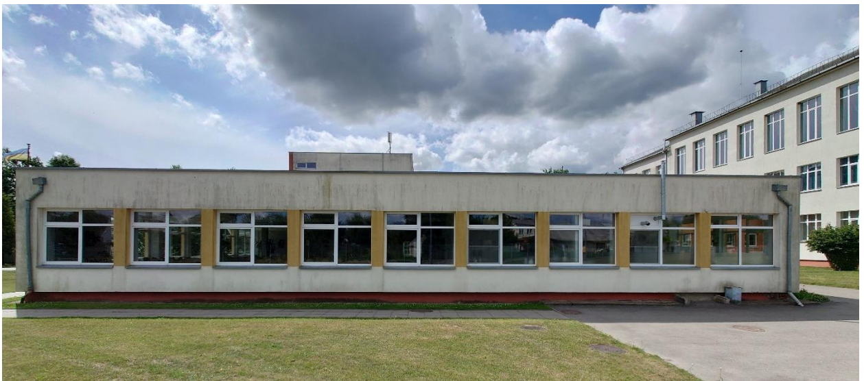
2 pav. Remontuojamo pastato fasado vaizdas.
