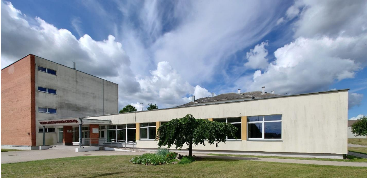
1 pav. Remontuojamo pastato fasado vaizdas.
