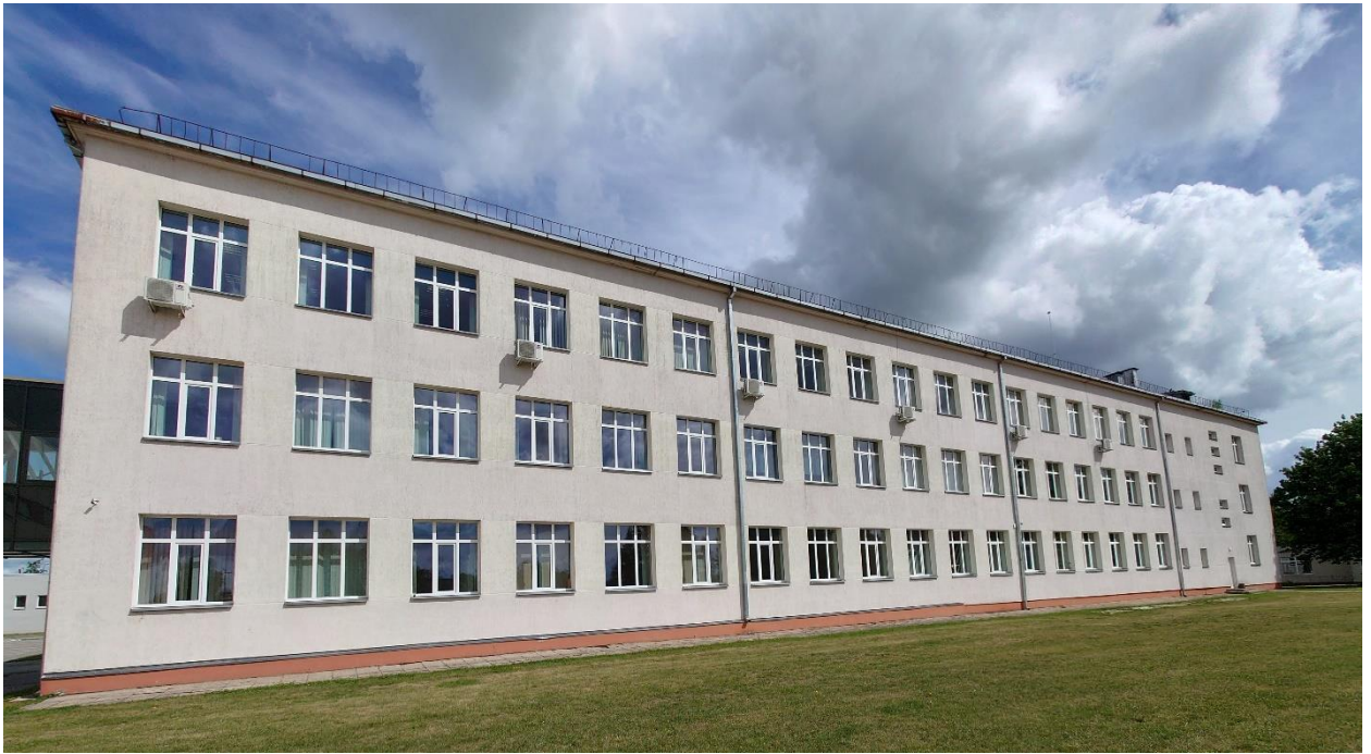
5 pav. Remontuojamo pastato fasado vaizdas.
