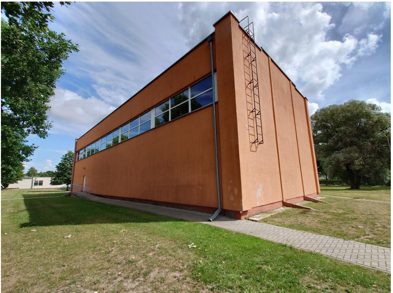
8 pav. Remontuojamo pastato fasado vaizdas.
