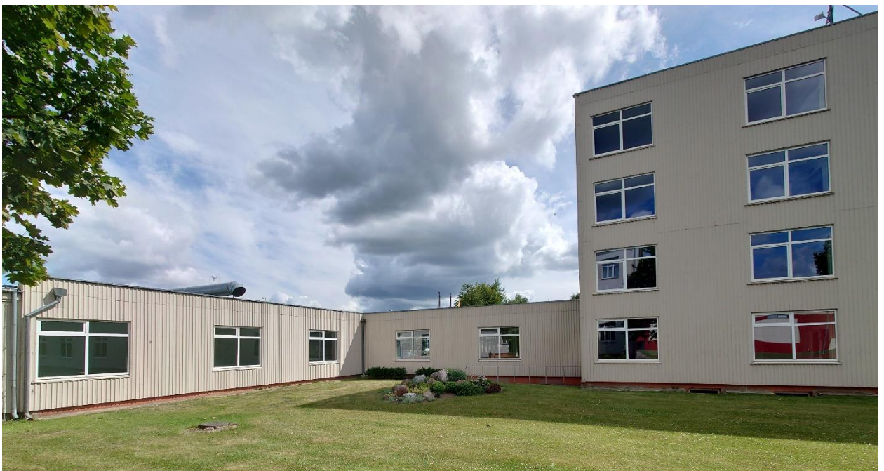
6 pav. Remontuojamo pastato fasado vaizdas.
