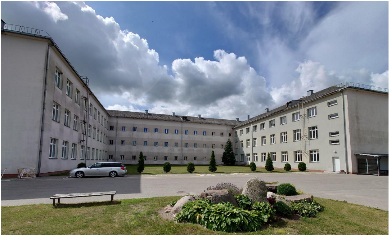
3 pav. Remontuojamo pastato fasado vaizdas.
