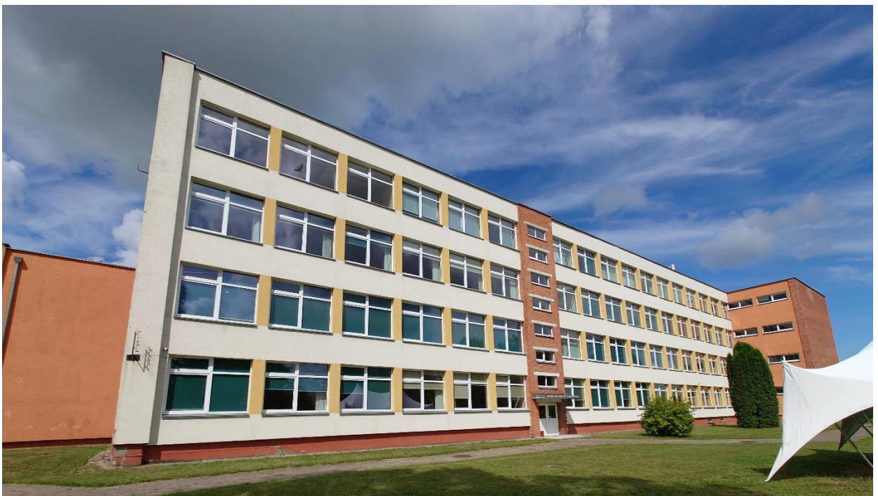
10 pav. Remontuojamo pastato fasado vaizdas.
