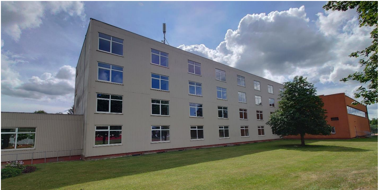
7 pav. Remontuojamo pastato fasado vaizdas.
