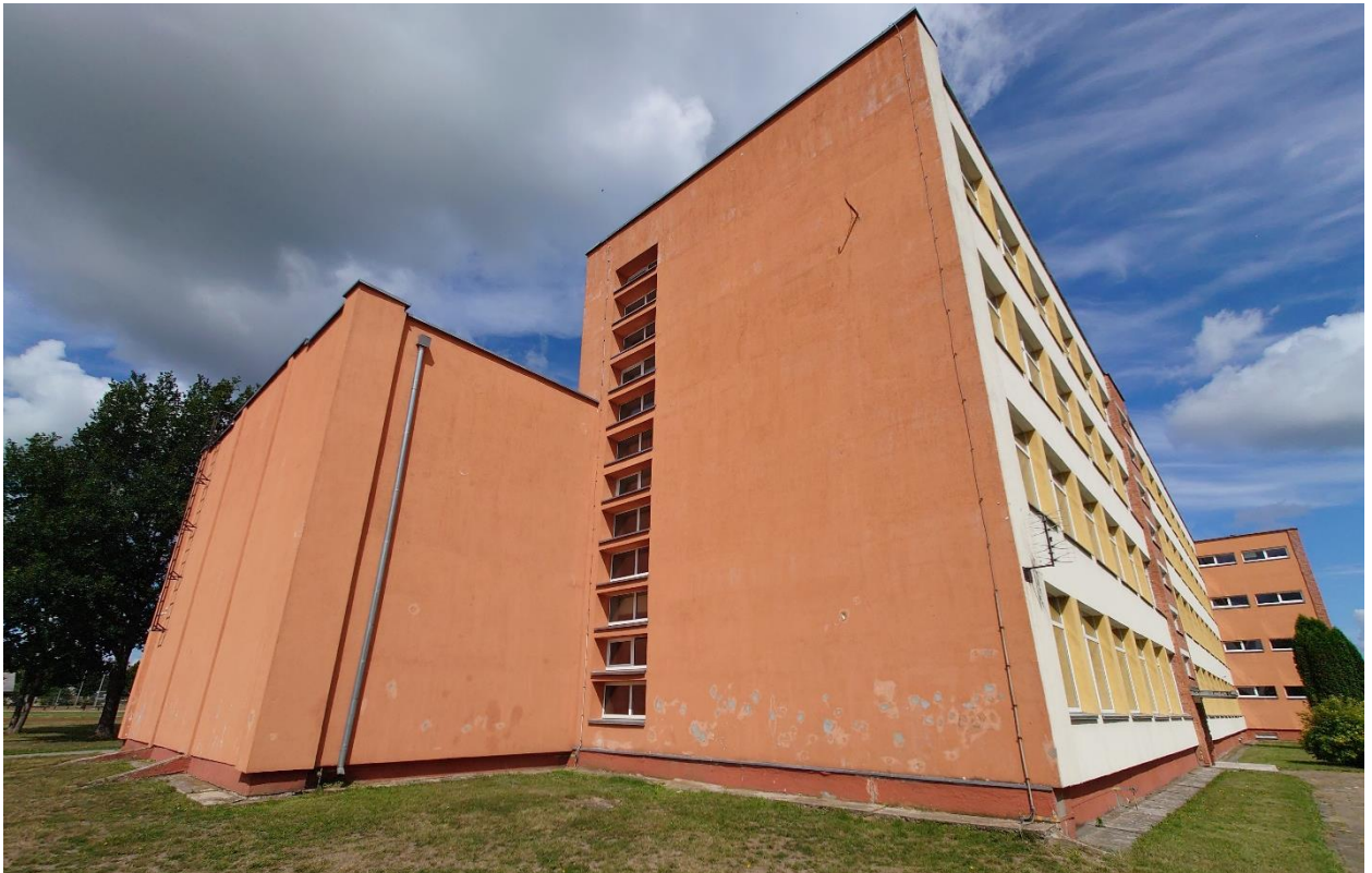
9 pav. Remontuojamo pastato fasado vaizdas.
