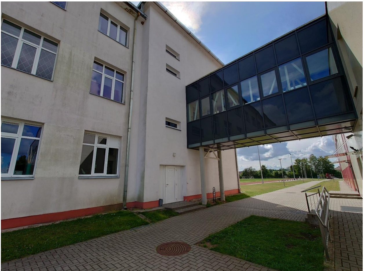
4 pav. Remontuojamo pastato fasado vaizdas.
