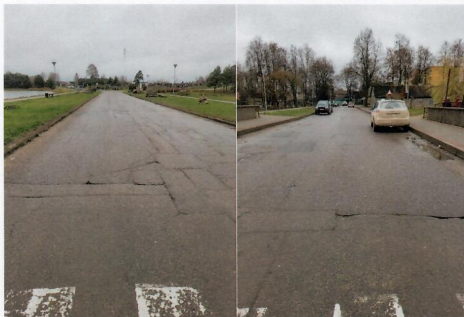
1 pav. GMU keteroje įrengto kelio paviršius nėra lygus, yra duobių, kuriose laikosi vanduo, atskiros paviršiaus vietos remontuotos, ties tilto siūlėmis matyti įtrūkimai
