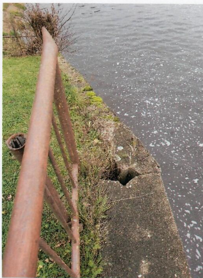
13 pav. Iširusi deformacinė siūlė kairės pusė ramte
