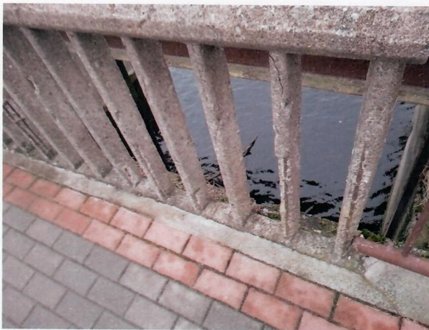
17 pav. Ties slenksčio ketveri esantys gelžbetoniniai turėklai apirę, matyti armatūra
