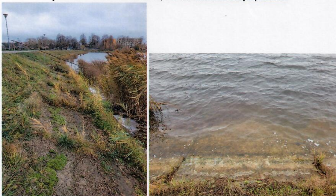
2 pav. Aukštutinio šlaito tvitinimo plokščių siūlėse auga žolė, ant paviršiaus auga samanos, siūlės po vandeniu išplautos
