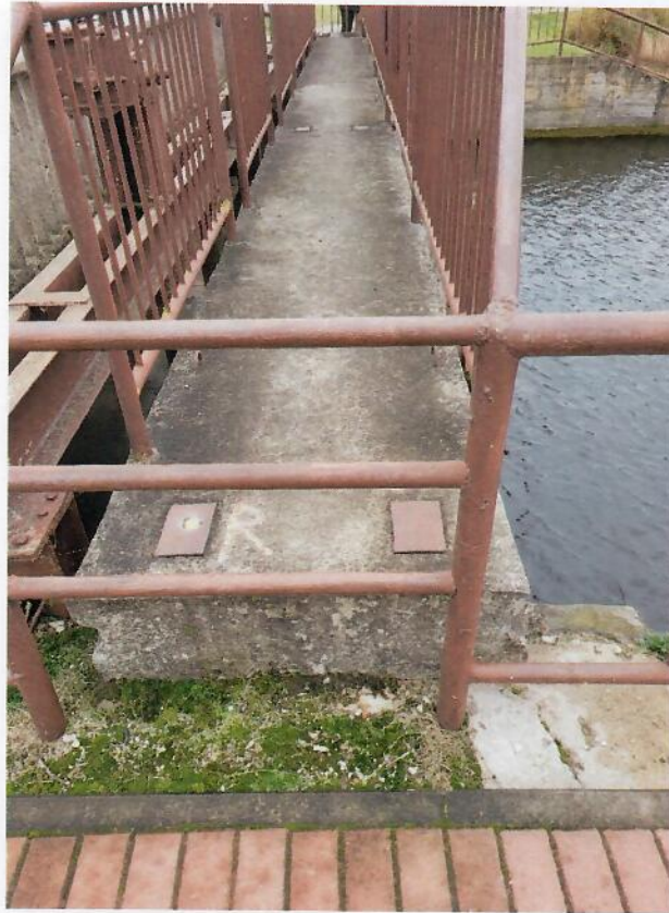
16 pav. Tarnybinio tiltelio būklė gera
