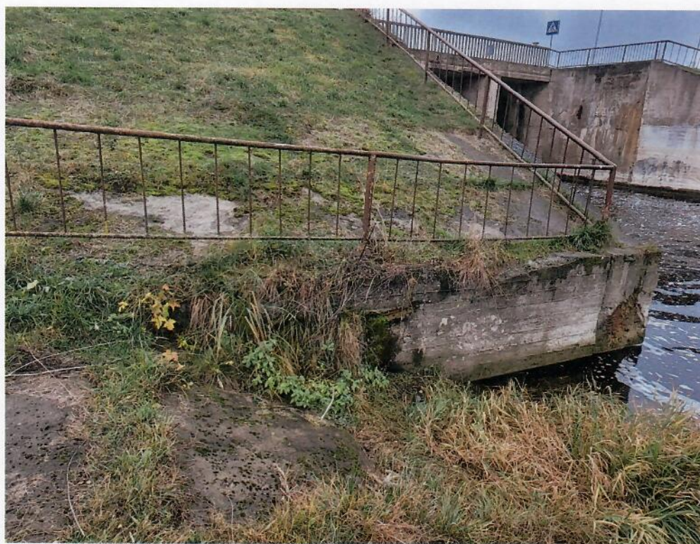
14 pav. Dešiniojo ramto galinės dalies paviršius stipriai pažeistas: matyti įskilimai, betono nuskėlimai, filtracijos požymiai
