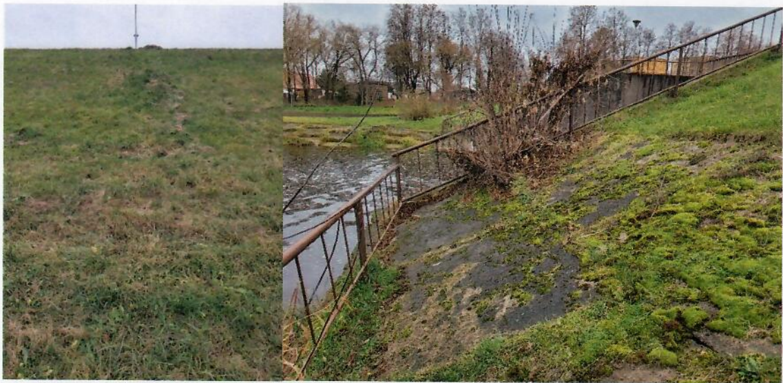
6 pav. Žemutinio šlaito kairėje pusėje formuojasi nuošliauža (kairėje), tvirtinimo plokščių paviršius paveiktas biokorozijos (dešinėje)
