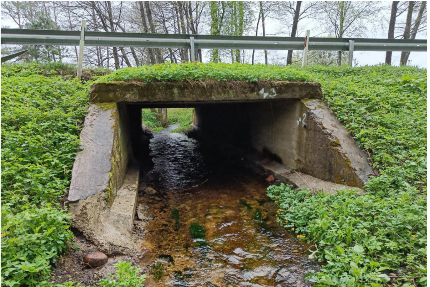
2 pav. Tilto per Šačios upę fasadinis vaizdas
