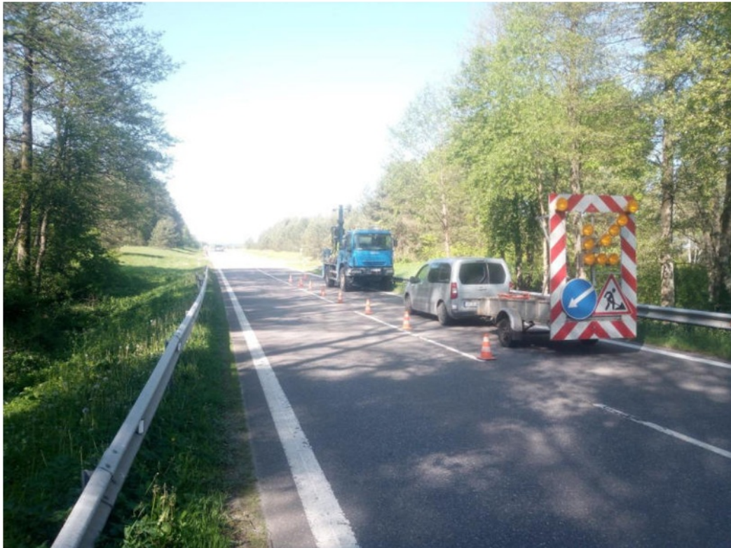
1 pav. Lauko darbai
