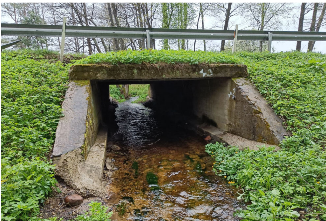
2 pav. Tilto per Šačios upę fasadinis vaizdas
