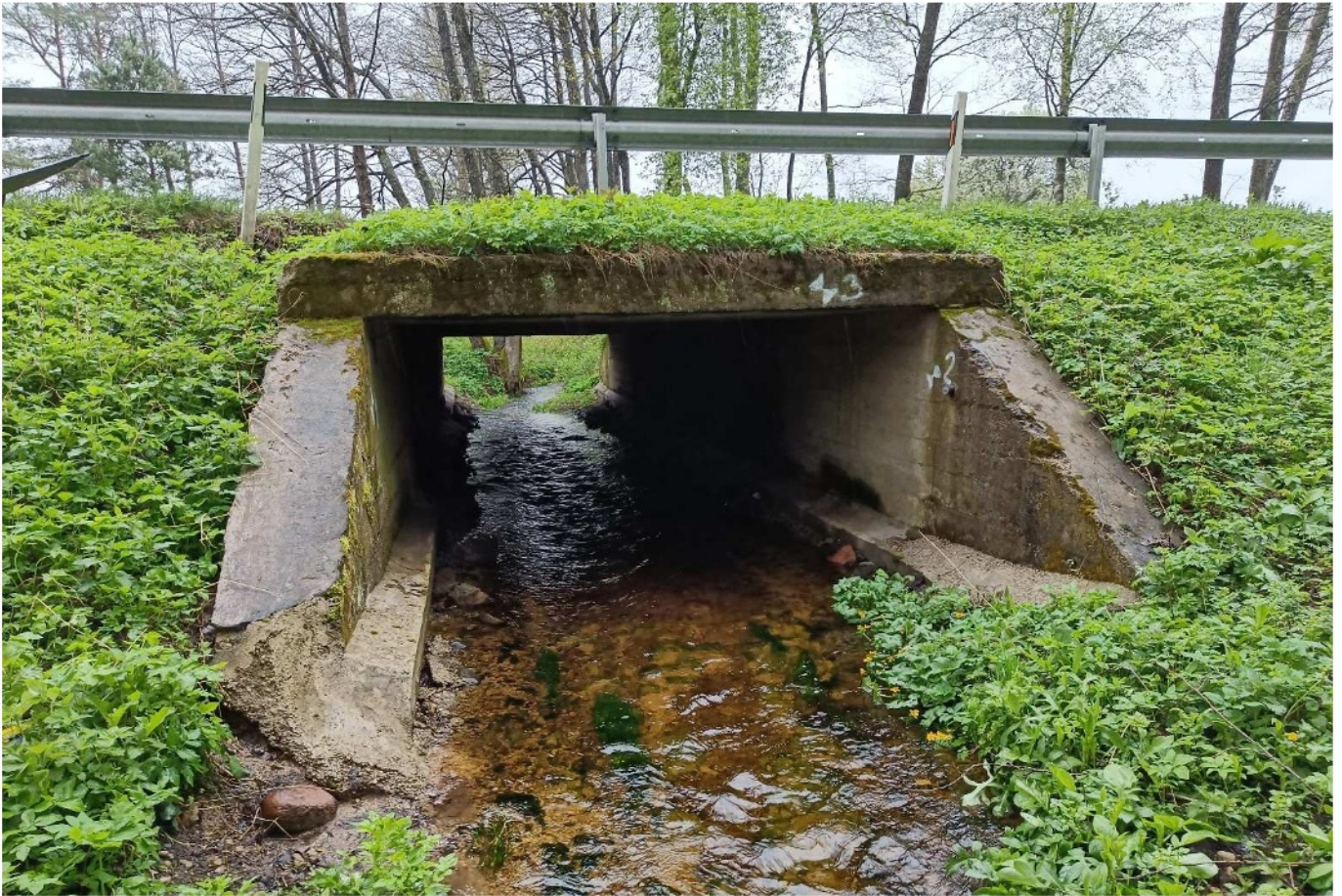
2 pav. Tilto per Šačios upę fasadinis vaizdas
