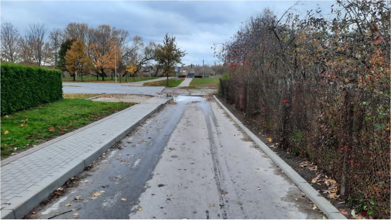
5 pav. Esamas kelias (aukštas šaligatvio kelkraštis, siauras asfaltuotas kelias skirtas vienpusiui judėjimui)
