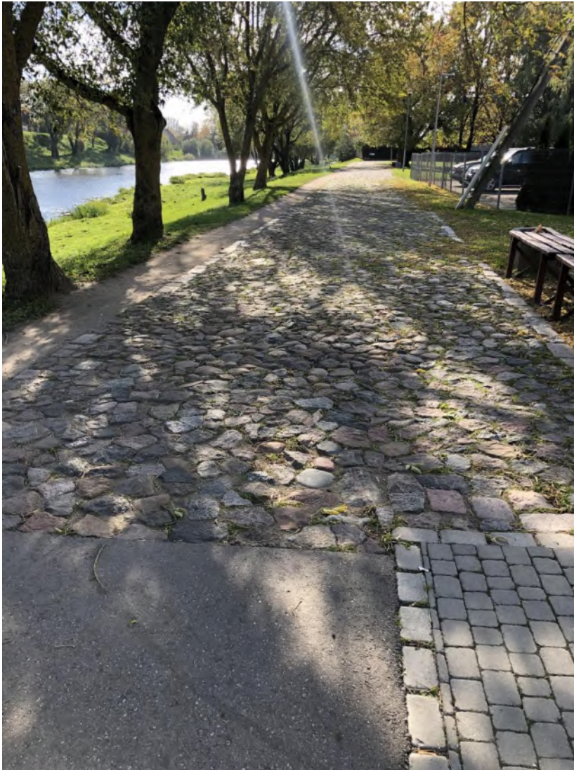
6 pav. Esamas tašytų akmenų grindinys, Kėdainių senasis uostas
