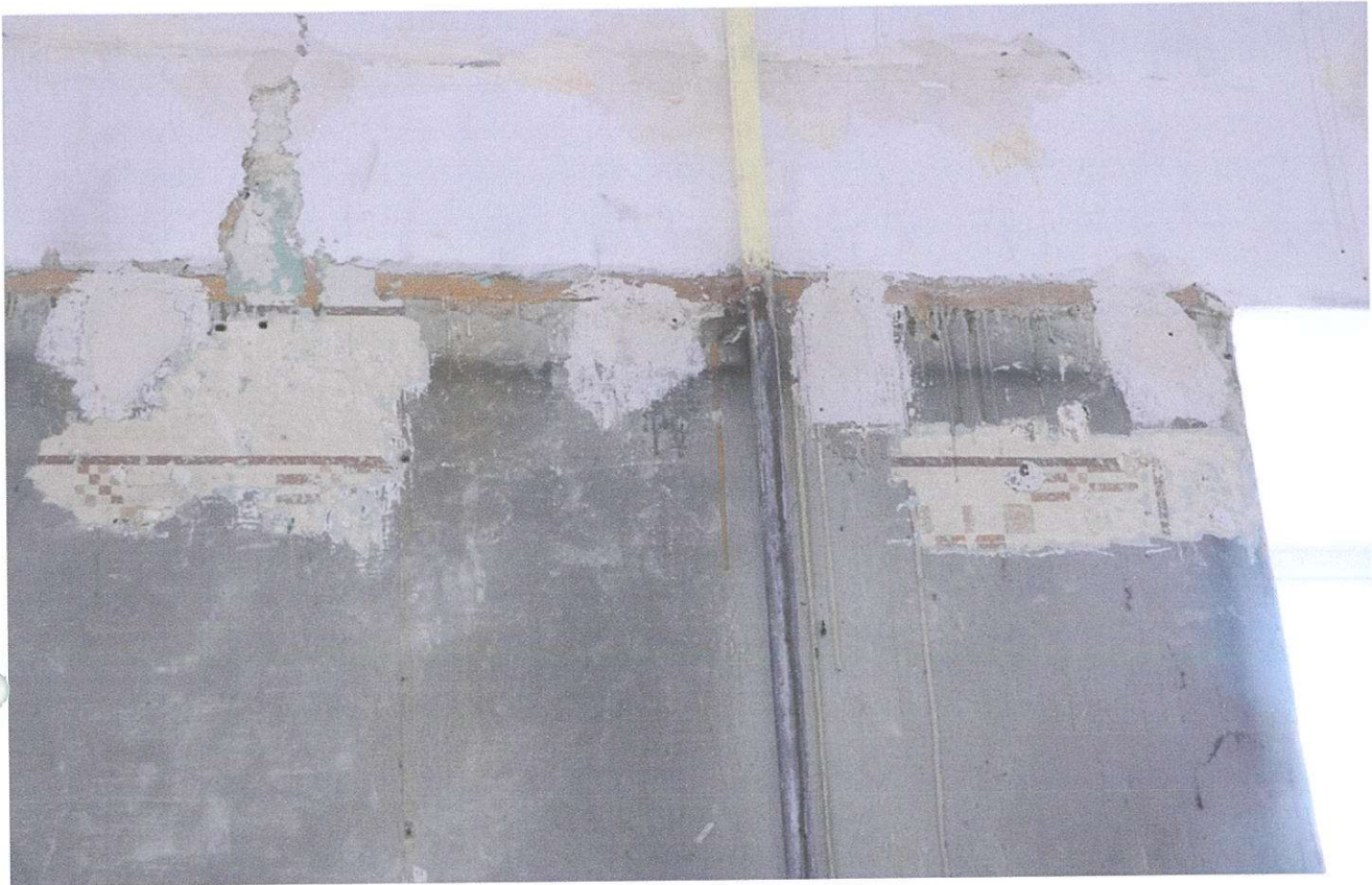
Fot. 2 Pirmas aukštas, patalpa Nr. 16 Atodangos viršutinėje sienos dalyje (9 sluoksnis)
