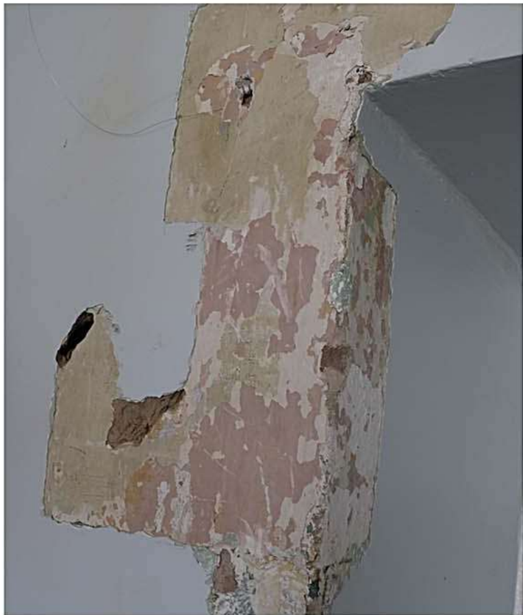
Fot. 16 Trečias aukštas, patalpa Nr., 3-3 Atodangos sienoje
