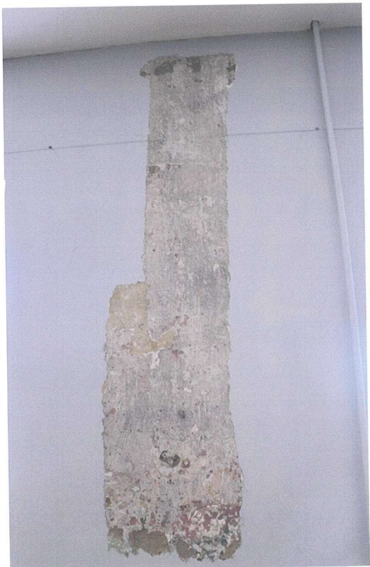
Fot. 11 Trečias aukštas, patalpa Nr. 3-3 Pirmo sluoksniu ant tinko atodanga
