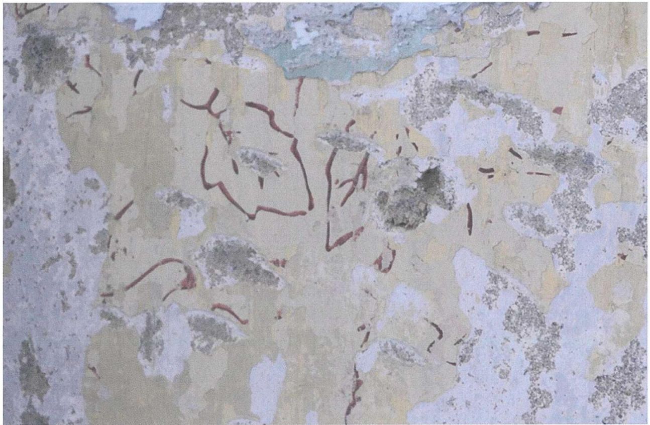
Fot. 6 Patalpa Nr. 16 Sienos puošybos atodanga (8 sluoksnis)
