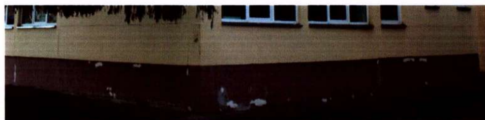
3 pav. Pažeistas pastato cokolis.
