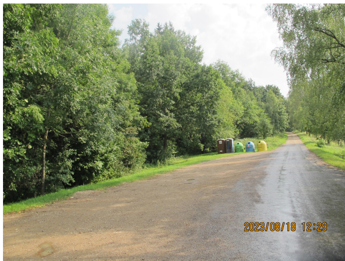
Eroduojantis automobilių parkavimo plotas. Vaizdas į R pusę
