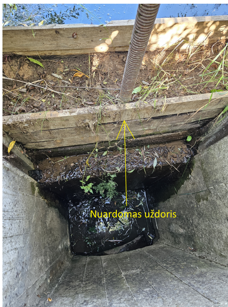
1 pav. Vandens telkinio nuleidimui išardoma skydo dalis šachtinėje pralaidoje
