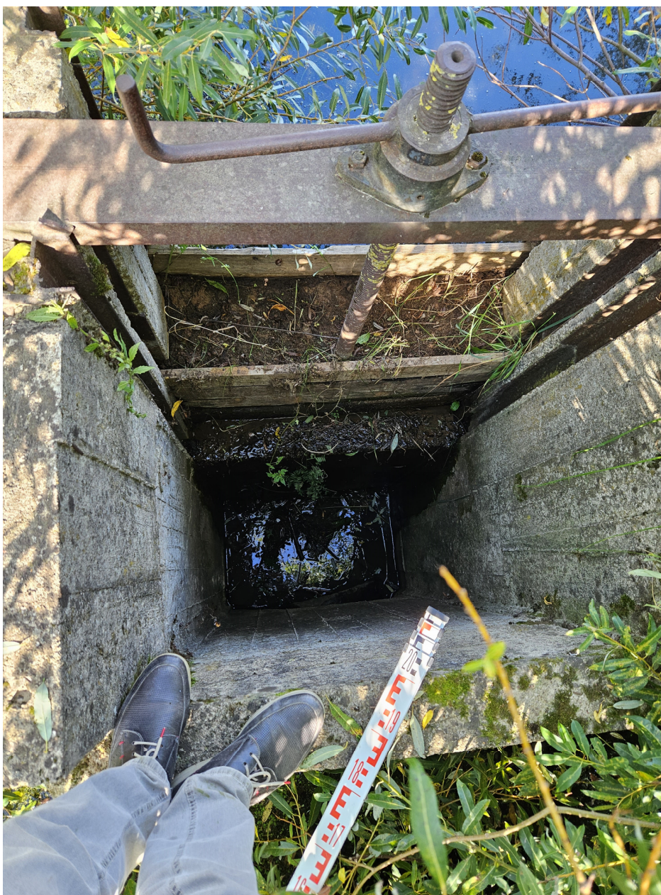
2 pav. Bendras šachtinės pralaidos vaizdas
