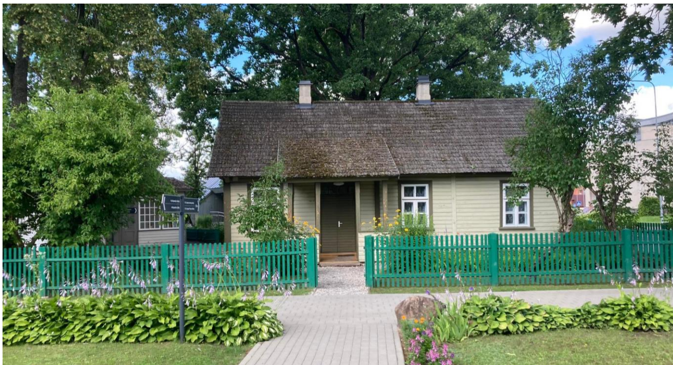
Sodybos namas iš rytų, būsimos aikštės pusės.
