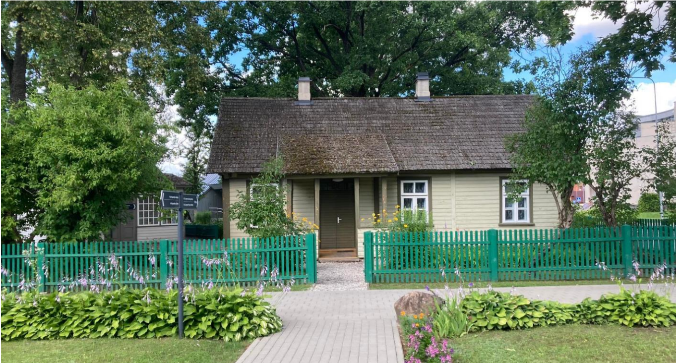
Sodybos namas iš rytų, būsimos aikštės pusės.
