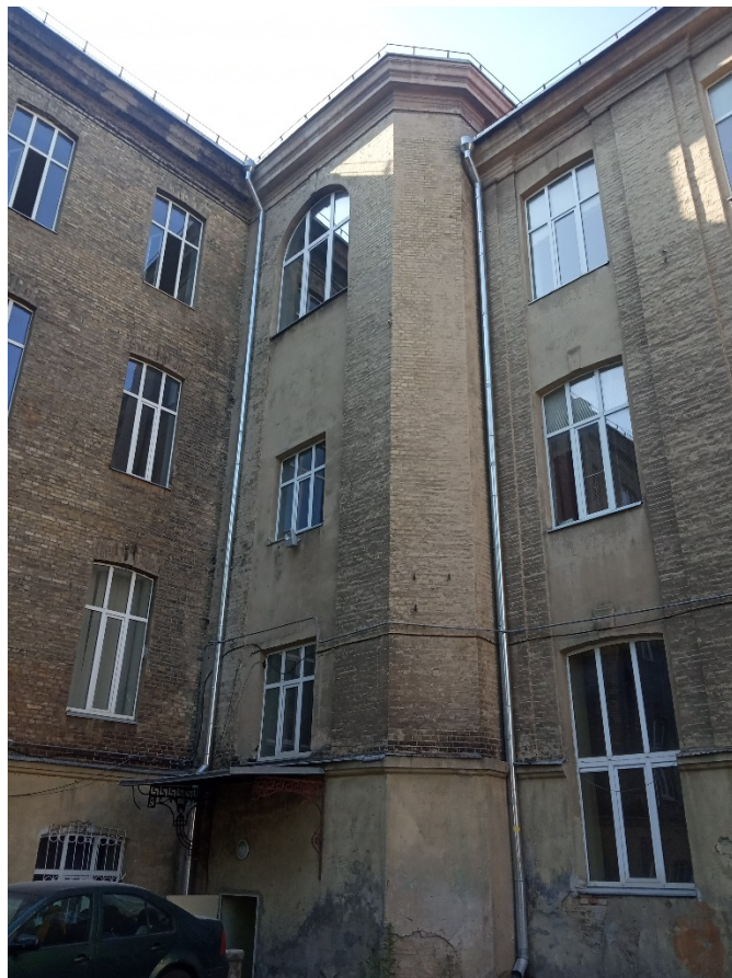
F 12 Tarpukario etapo kiemo fasadas su netinkuotų geltonų plytų mūro piliastrais
