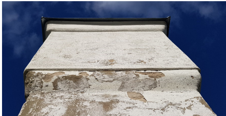
FF-11. Antkapinės koplytėlės P fasado fragmentas: II tarpsnio apvalaus profilio karnizas
