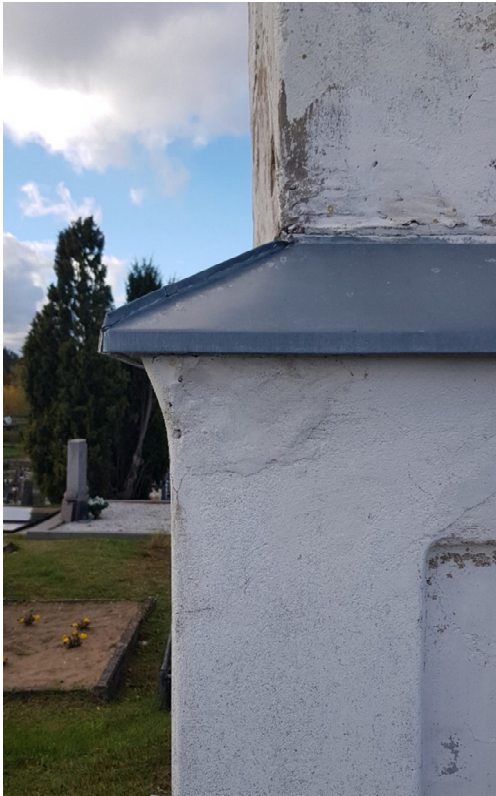
FF-9. R fasado fragmentas: I ir II tarpsnio apskardintas tarpaukštinis karnizas
