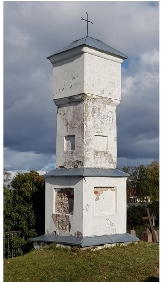
FF-2. Antkapinės koplytėlės V ir P fasadai. Vaizdas iš PV pusės
