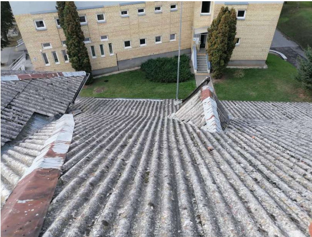
12 nuotrauka. Palėpės ventiliacinis stogelis. Kraige trūksta dalies skardos, vanduo prateka kiaurai. Vėjaskardė atsokusi, deformuota.
