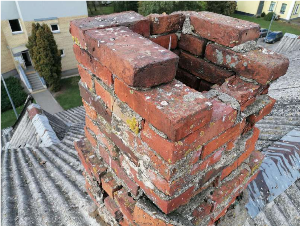
11 nuotrauka. Atmosferos kritulių pažeista vėdinimo šachta.
