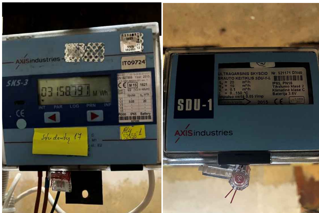
Pav. 2, 3. Esamo šilumos skaitiklio fotografacija.
