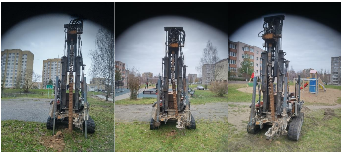
1-3 pav. Lauko darbai.
