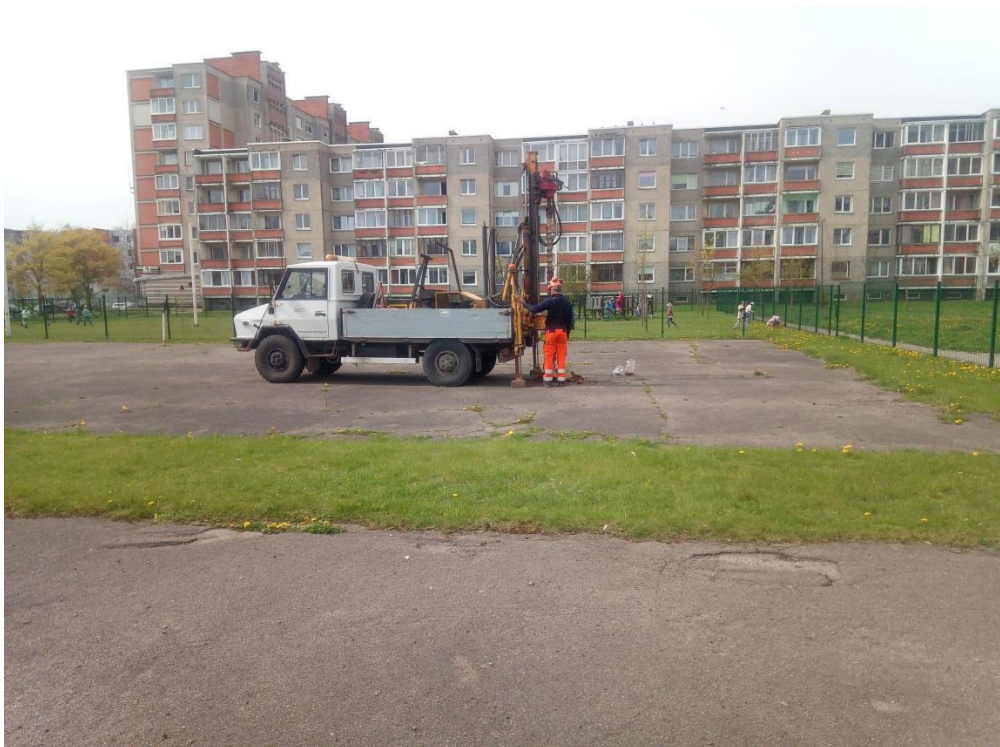
1 pav. Lauko darbai
