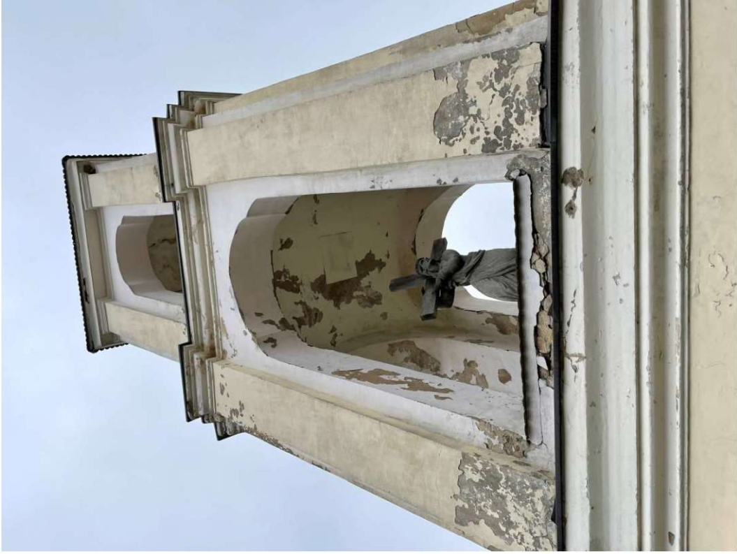
Nuotrauka Nr. 5. II tarpsnio fragmentas iš arčiau. Matosi skliautuotos lubos, dažytos, dažai atsilupę. Karnizas apskardintas, dažytas. Matosi vidinių ir išorinių fasadų defektai.
