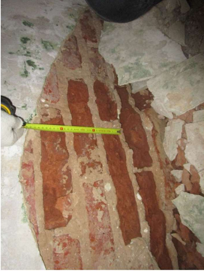
Nuotrauka Nr. 24. Tyrimų metu atlikti matavimai. Plytų išmatavimai: 30x7(h) cm
