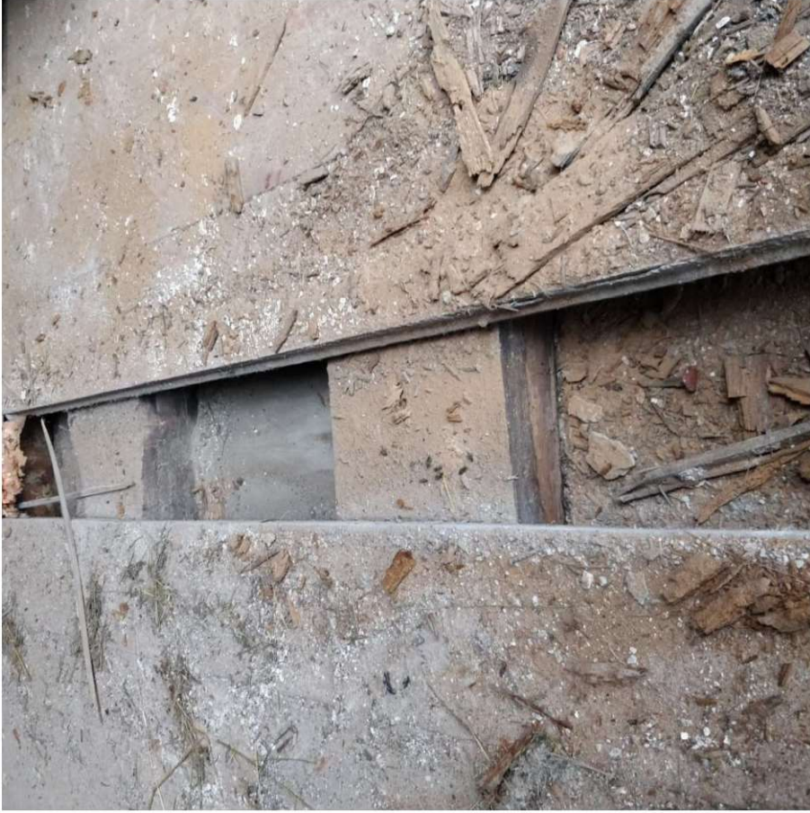
Nuotrauka Nr. 15. Grindų konstrukcijos fragmentas. Ant skiedinio užtepo įrengti gulekšniai ant jų išsistinis grindlencčių paklotas, tarp gulekšnių tarpai užpilti biriu smėliu. Gulekšniai apsaugoti ruberoidu.
