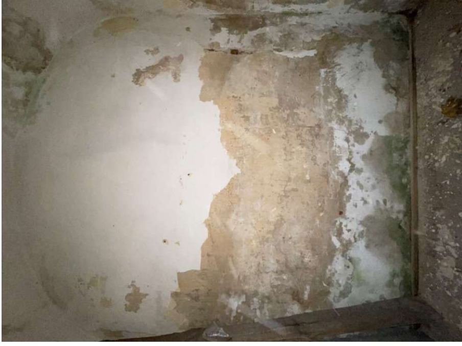
Nuotrauka Nr. 12. Kopyčios vidaus interjeras tarp ašių „A-B“. Matosi erodavęs tinkas, matomos biopazaidėjų kolonijos. Grindys grindlėnčių.
