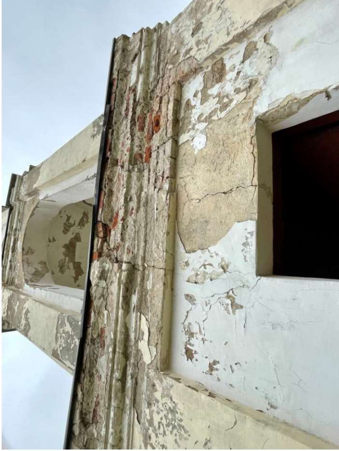
Nuotrauka Nr. 7. Fasado fragmentas ašyje „A“. Virš įėjimo durų suplyšusi pleištinė sgrama. Išlikęs autentiškas tinkas ir mūro fragmentai. Matosi eroduotos karnizo tinko traukės.
