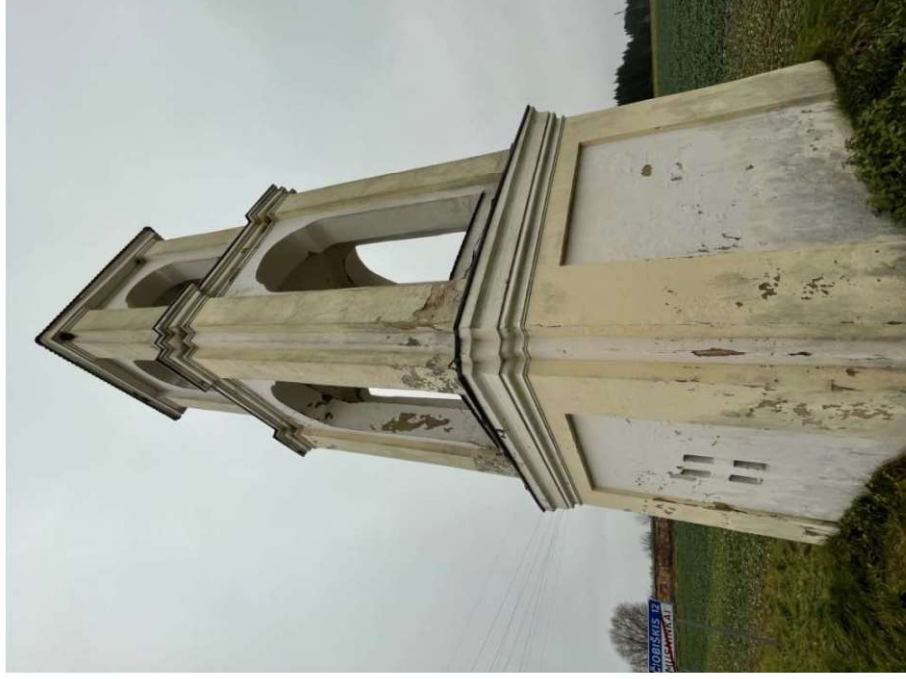
Nuotrauka Nr. 2. Koplytėlės bendras vaizdas ašyje „B“ ir „2“. Matosi pažeisti dažyti paviršiai. Nuogrinda neįrengta. Kopyčios stogų danga medinių čerpių – malksnų. Karnizai apskardinti.
