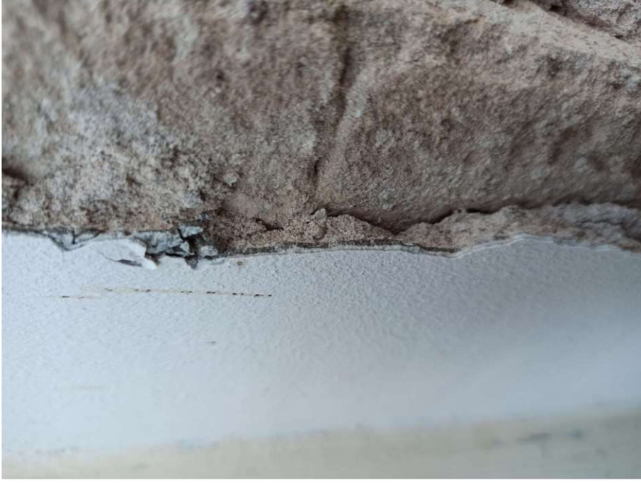
Nuotrauka Nr. 21. Tinko fragmentas iš arčiau. Esamas tinkas ~15 mm storio, 2 užtrynimai ~5 mm storio, tinkas atšokęs nuo pagrindo.
