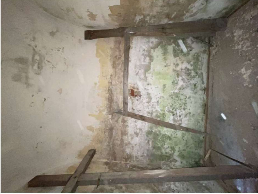
Nuotrauka Nr. 9. Kopyčios vidaus interjeras tarp ašių „A-B“. Matosi eridavęs tinkas iki skliauto pėdos ir nežymiai skliaute. Skliautas mūrinis, cilindrinis tinkuotas.
