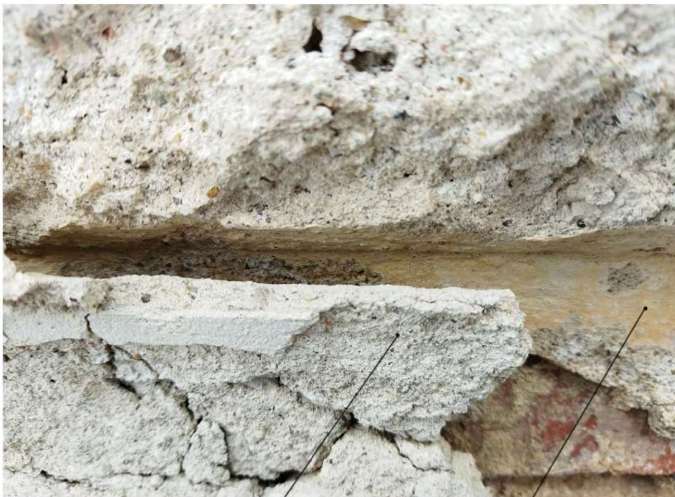
Fot. 6 Antras tinko sluoksnis Ankstyviausias dažytas sluoksnis
