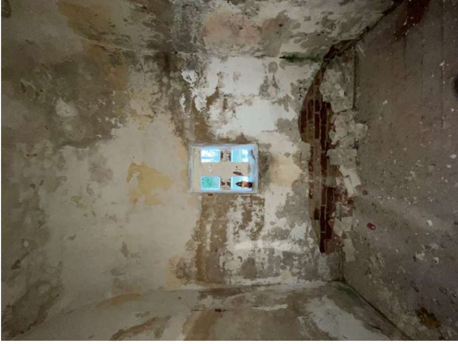
Nuotrauka Nr. 10. Kopyčios vidaus interjeras tarp ašių „B-A“. Matosi mūrinis nestiklintas langelis graikiško kryžiaus formos. Tinkas erodavęs, matosi atviras plytų mūras.
