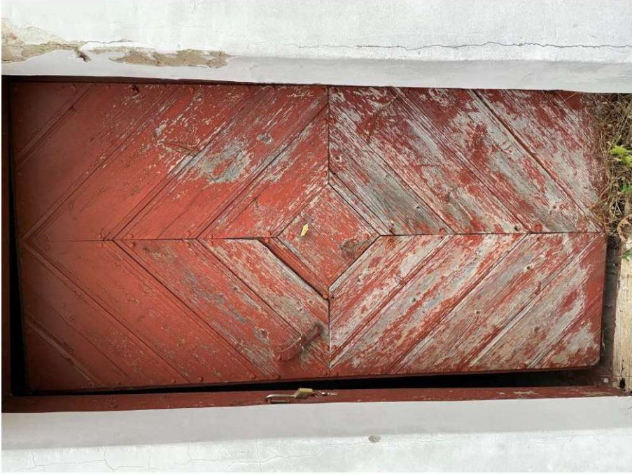
Nuotrauka Nr. 13. Kopytelės durų fragmentas. Durys apkaltos iš išorės lentomis rombu, dažytos, dažai apsilaupę. Varcia į vidų. Durys įrengtos 1979 m projekto metu.
