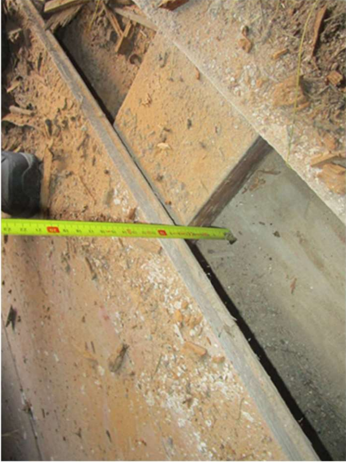
Nuotrauka Nr. 23. Tyrimų metu atlikti matavimai. Grindų bendras sluoksnių storis ~10 cm nuo cementinio užtepo.
