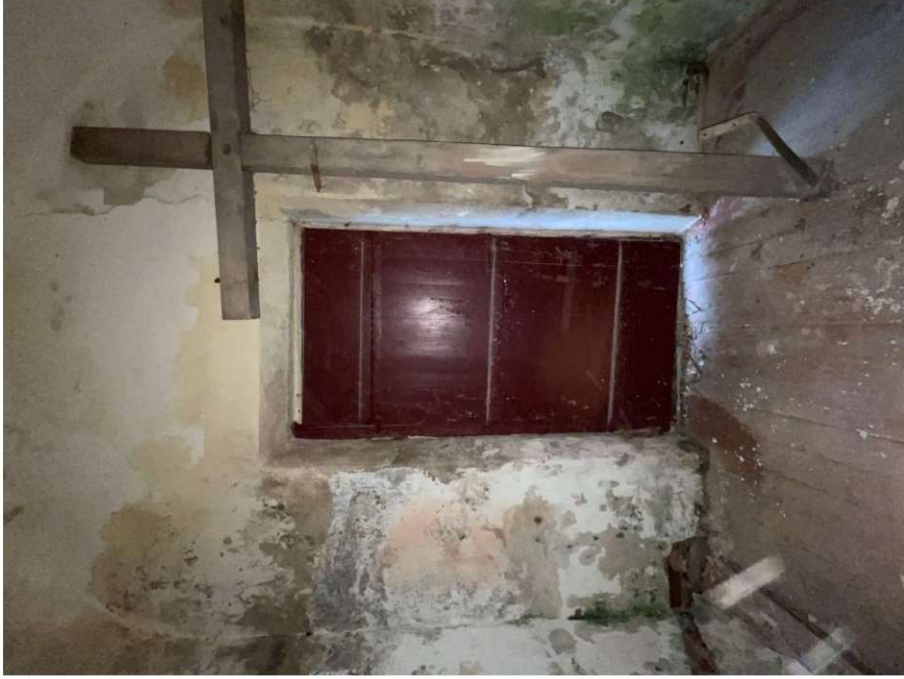
Nuotrauka Nr. 11. Kopyčios vidaus interjeras tarp ašių „2-1“. Matosi durys su varčia į vidų. Durų vidinė pusė vertikalių lentų su trimis įpjautais skersiniais. Tinkas erodavęs, matomos biopazaidėjų kolonijos. Grindys grindlėnčių statmenai durims.
