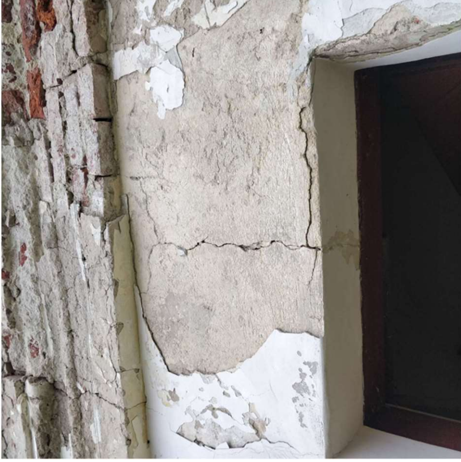
Nuotrauka Nr. 6. Fasado fragmentas ašyje „A“. Virš įėjimo durų suplyšusi pleištinė sgrama. Išlikęs autentiškas tinkas ir mūro fragmentai. Matosi eroduotos karnizo tinko traukės.
