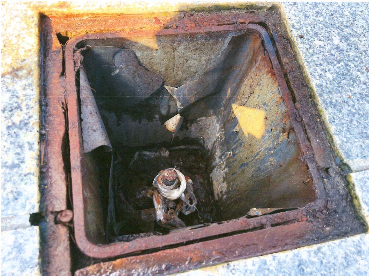
Inkaravimo varžtas eglutės stovo tvirtinimui
