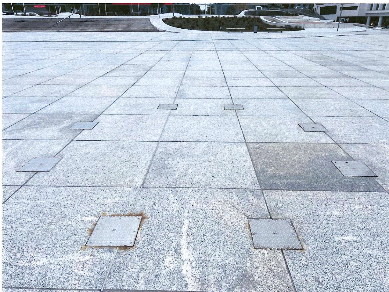
Nerūdijančio plieno dangčiais uždengtos eglutės stovo tvirtinimo vietos.
