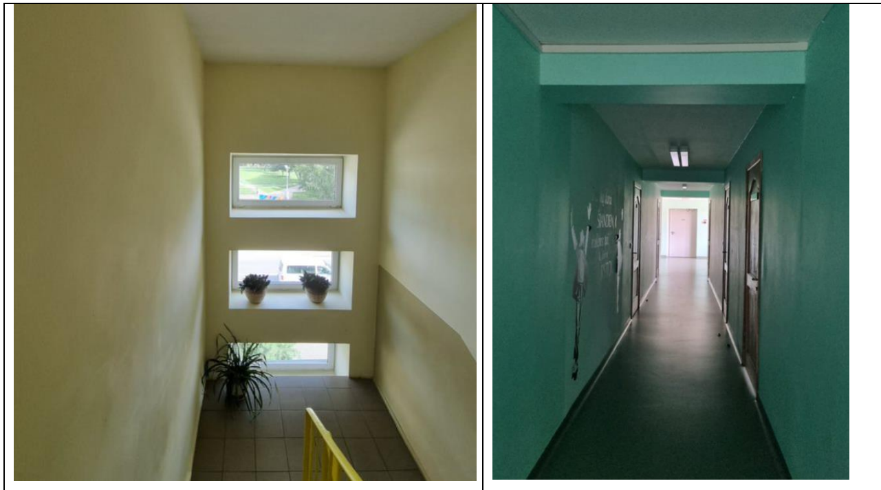
Pav. 3 Laiptinės apšvietimas. Evakuacijos kelių apdaila
