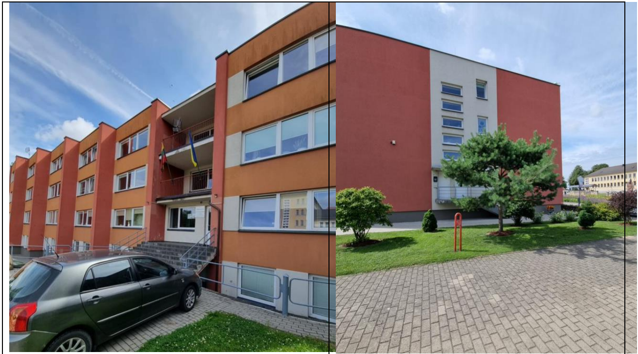
Pav. 1 Pastato vaizdas iš gatvės. Hidranto vietos žymėjimas
