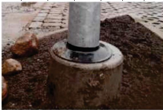
Apšvietimo atramos pamato ir pamato apsauginės gumos vaizdas
