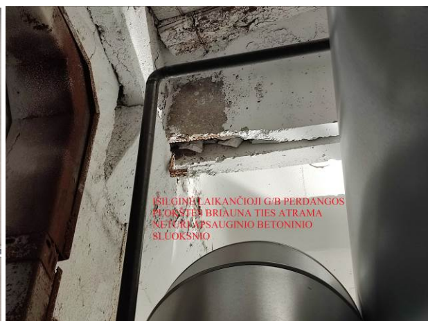
Nuotrauka Nr. 3, 4 (Defektai I-ojo aukšto konstrukcijose)
