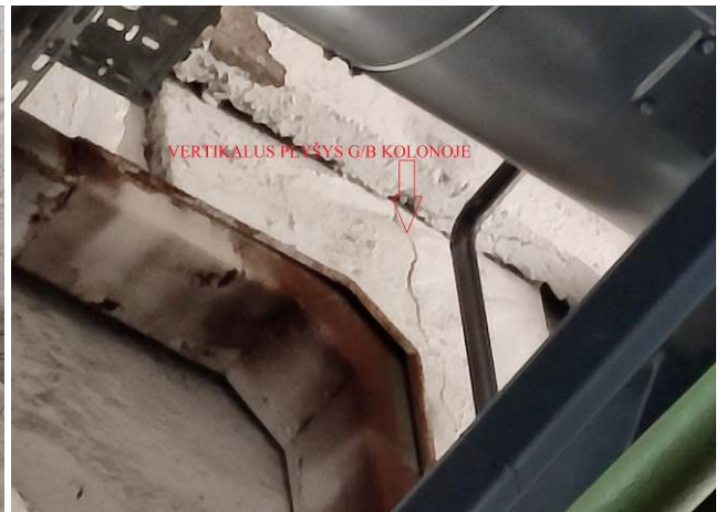
Nuotrauka Nr. 5, 6 (Defektai I-ojo aukšto konstrukcijose)
