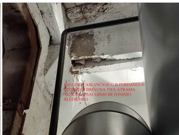
Nuotrauka Nr. 3, 4 (Defektai I-ojo aukšto konstrukcijose)
