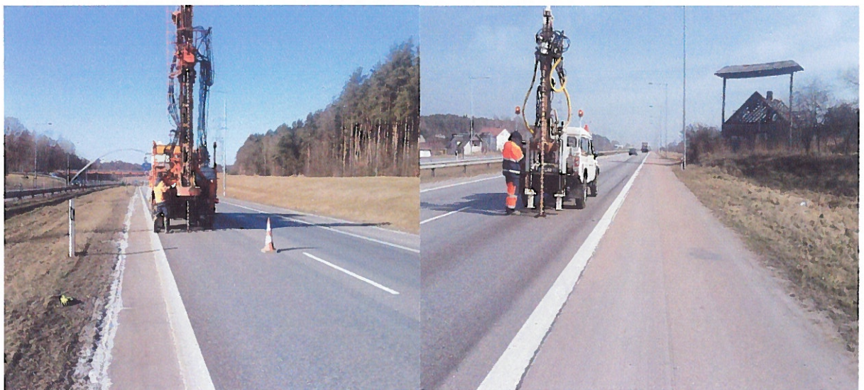
Foto1. Gręžinio Nr. 41 gręžimas agregatu H-35SL dešinėje kelio pusėje, 2-oje eismo juostoje.
