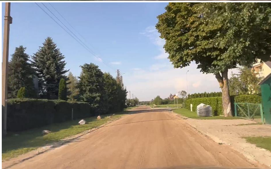
1 pav. Esamos gatvės būklės fotofiksacija
