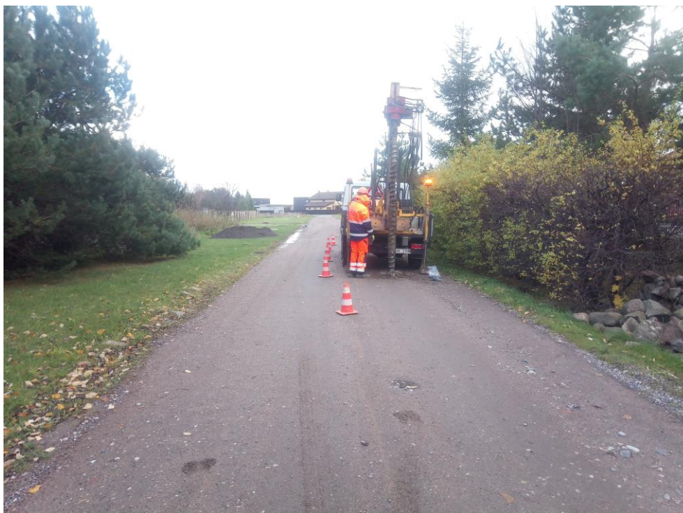
1 pav. Lauko darbai
