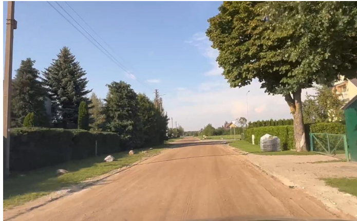
1 pav. Esamos gatvės būklės fotografacija
