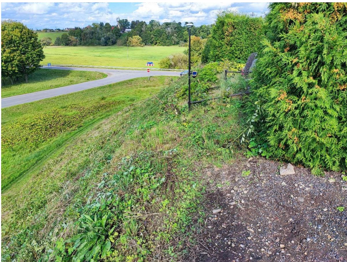
3 nuotr. Grunto sąslūga Papilės I plkn. ŠV šlaito viršutinėje dalyje ties S. Daukanto kapaviete (ET profilyje-1 pažymėta anomalija 26-34 m intervale, žr. 8 pav.)
