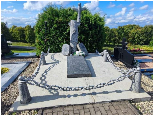
11 nuotr. 2-5 mm skersmens plyšiai S. Daukanto kapavietės postamente rodo netolygų gruntų sėdimą
