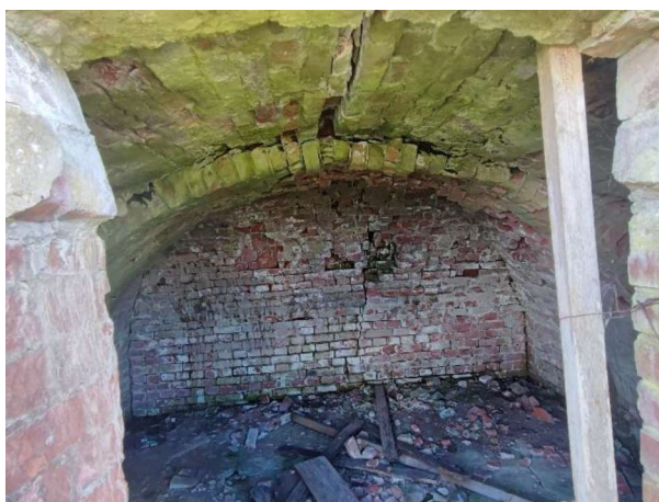
10 nuotr. Plyšiai besideformuojančioje kriptoje Š R kapinių dalyje (įgilinta viršutinėje šlaito briaunoje)
