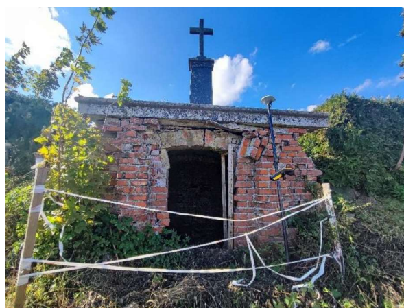
10 nuotr. Plyšiai besideformuojančioje kriptoje Š R kapinių dalyje (įgilinta viršutinėje šlaito briaunoje)
