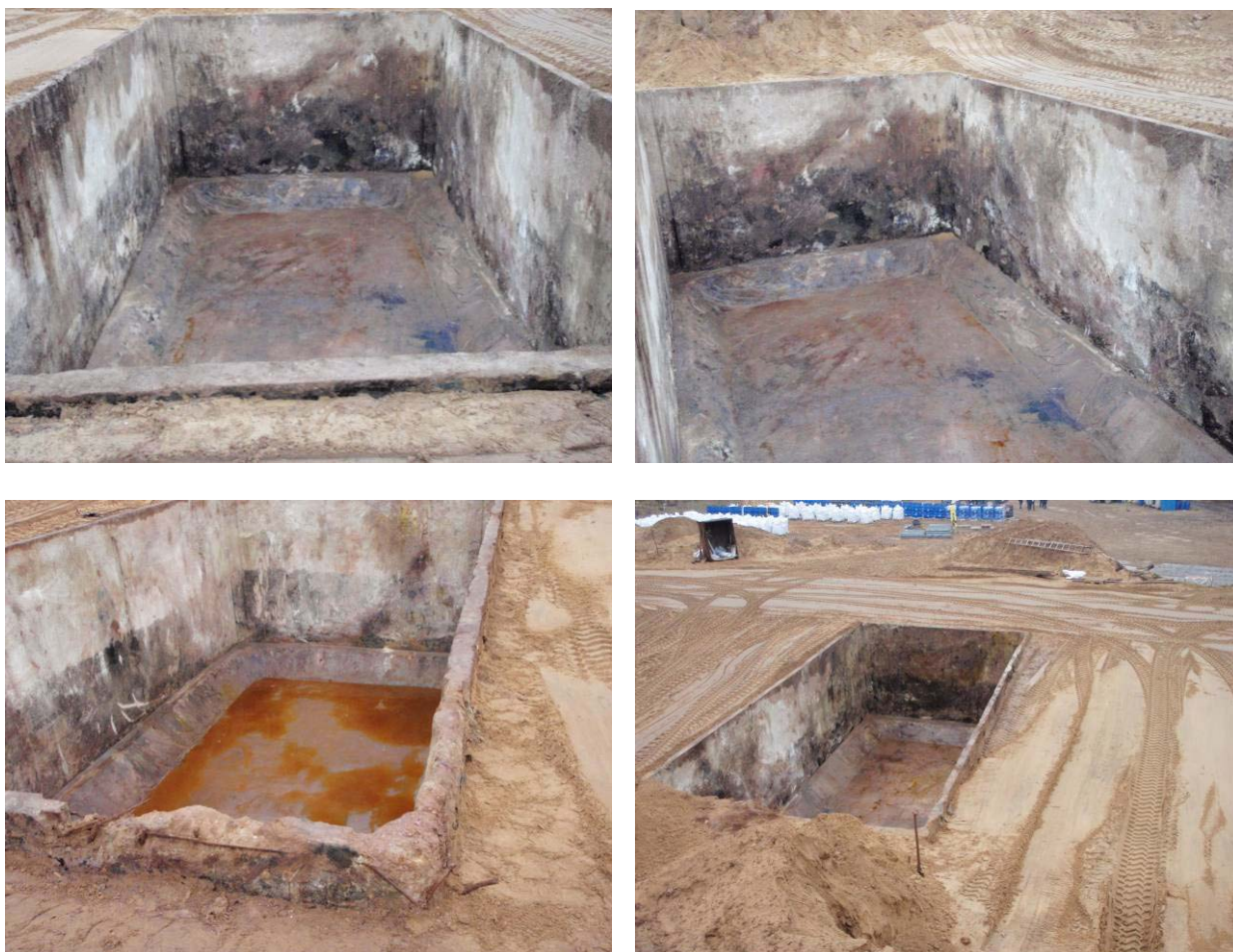
4 pav. Atkastos ir išvalytos nuo pesticidų požeminės talpos Žygantiškėse
