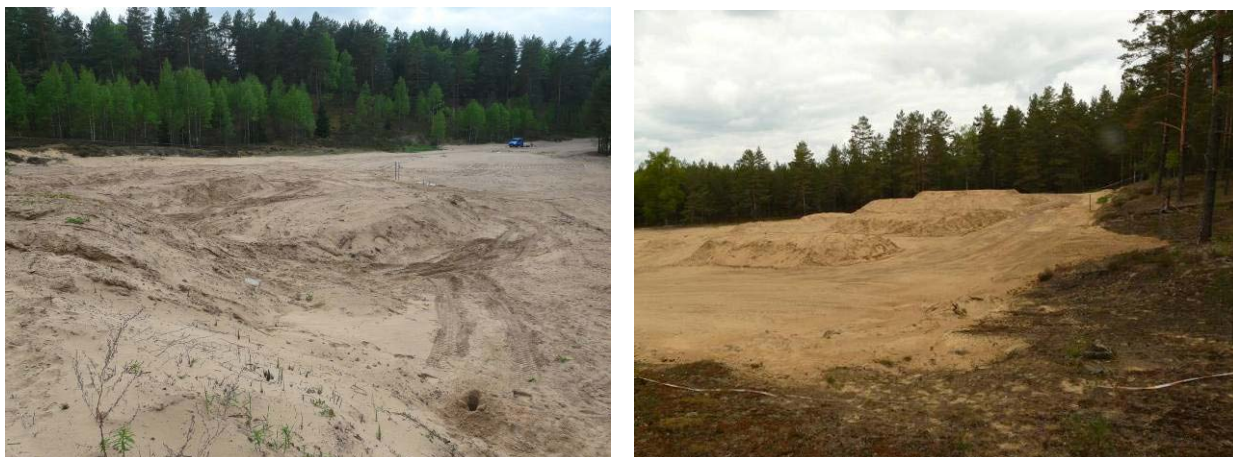
5 pav. Uždengtos ir užpiltos gruntu talpos Žygantiškėse
